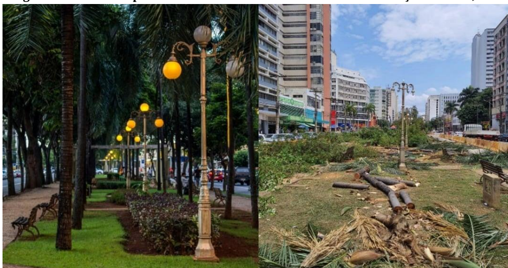
Figura 73. Antes e depois da Avenida Goiás durante obras de instalação do BRT, 2022
