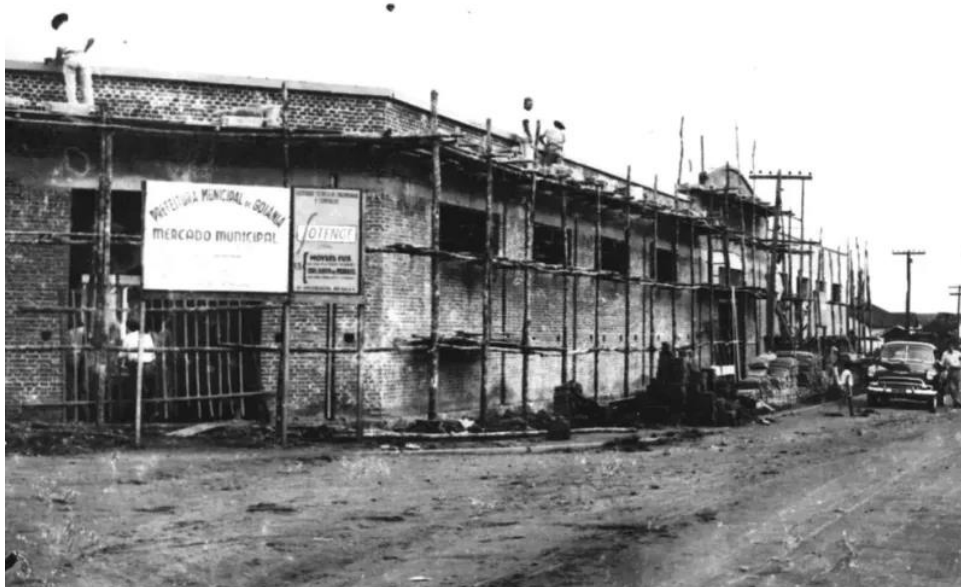
Figura 12. Registro do Mercado Municipal sendo construído na década de 50
