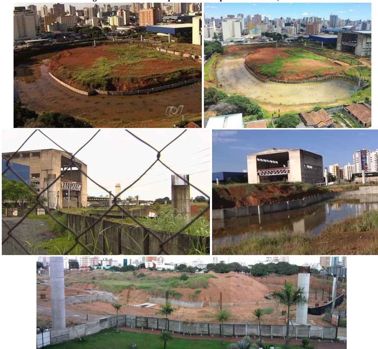
Figura 39. Estádio Olímpico durante o período de obras, 2012
