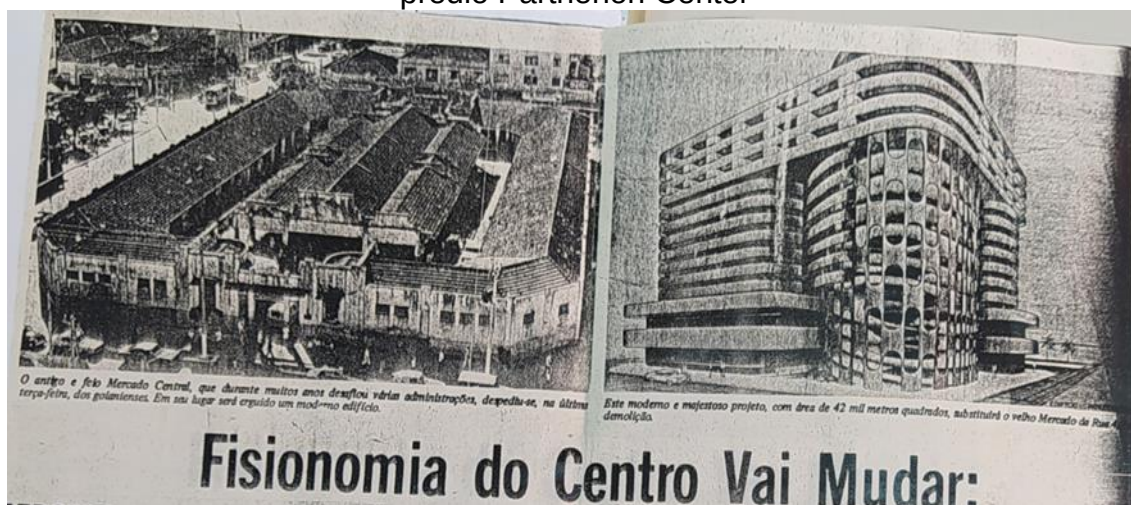
Figura 11: Área do Mercado Central na rua 4 - Centro cede lugar para ser o prédio Parthenon Center
