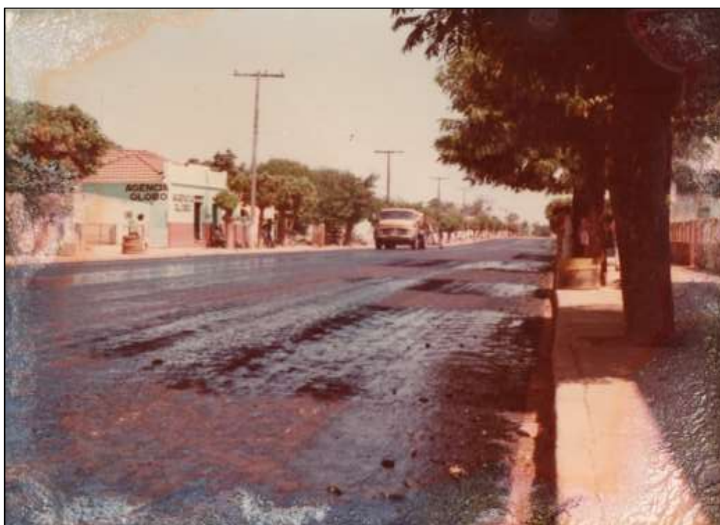
Figura 4: Chegada do asfalto em Firminópolis – GO
