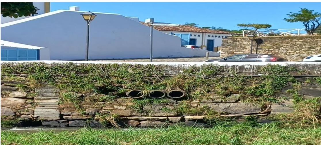
Figura. 66 – Resquícios do extinto Porto ou Cais do Rio Vermelho (detalhe das colunas de blocos de pedra emoldurando as laterais das velhas manilhas do esgoto de 1873). Antes desta parede de pedras na barranca havia uma rampa de acesso para as canoas entre as duas colunas. Ao fundo o muro de arrimo da fachada da Igreja São Francisco de Paula, em cuja base funcionava o extinto Chafariz da Igreja São Francisco. Fonte: José Maria (2023)
