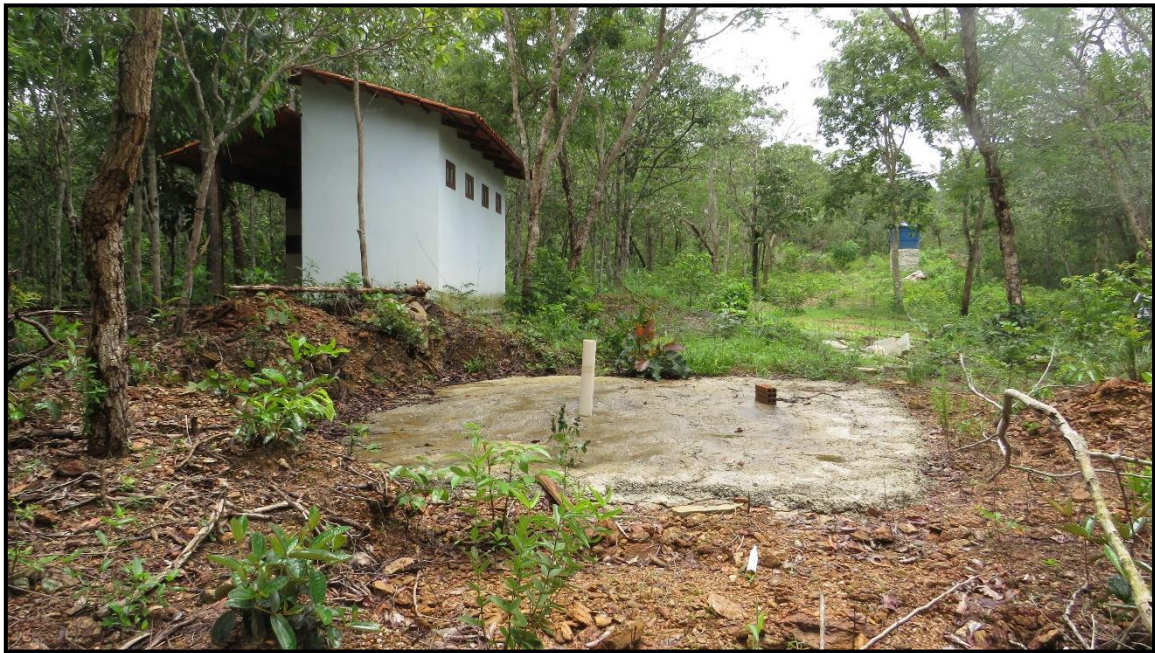
Figura 59: no primeiro plano a fossa com a tubulação para 'respiro', à esquerda a estrutura dos banheiros, e bem ao fundo, a caixa d'água plástica azul sobre uma estrutura de pedras. Fonte: trabalho de campo realizado em fevereiro de 2024.
