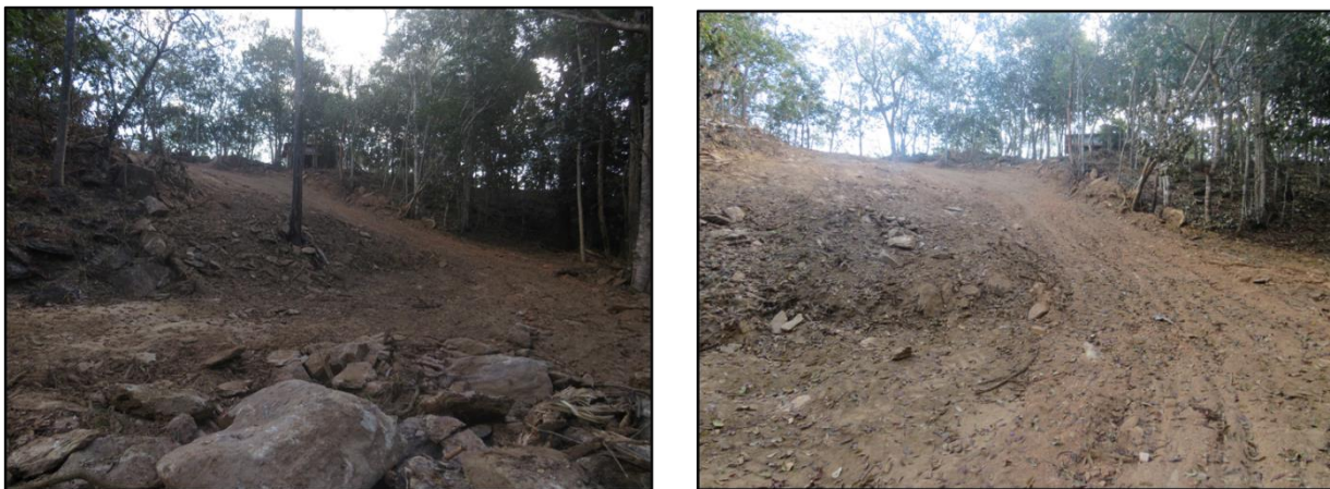
Figura 61: detalhes da ‘rampa de acesso’ aberta para a beira do Rio das Pedras. Fonte: trabalho de campo realizado em 2022.
