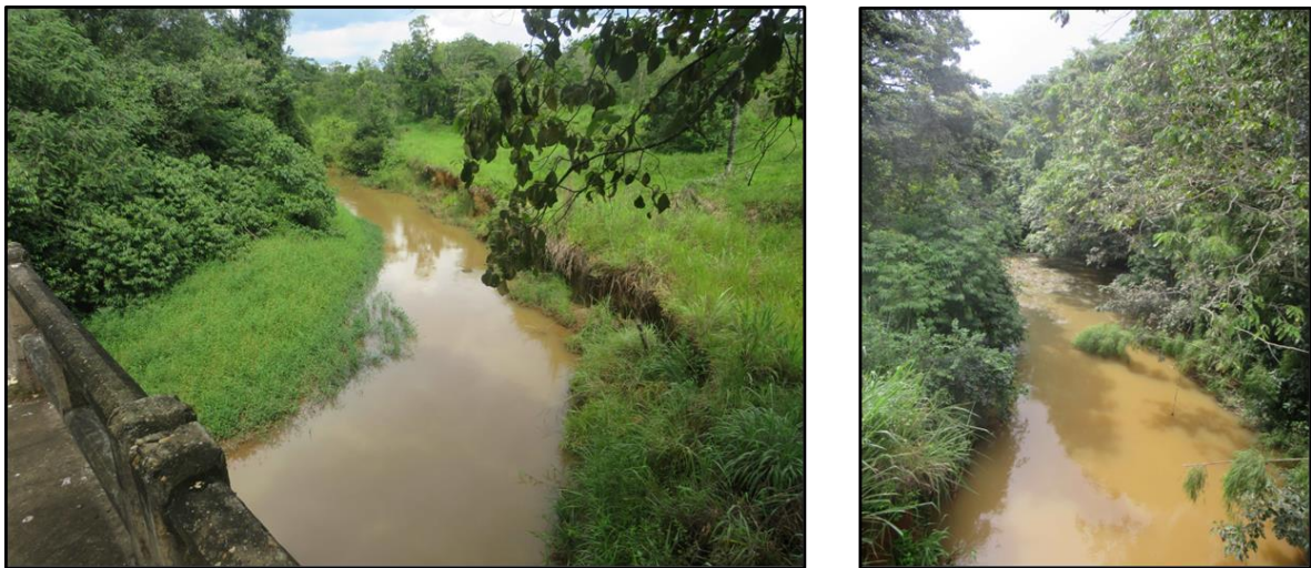
Figura 51: Fotos do Rio das Pedras na GO-431: à esquerda, a montante da ponte; à direita, a jusante. Fonte: trabalho de campo de fevereiro de 2024
