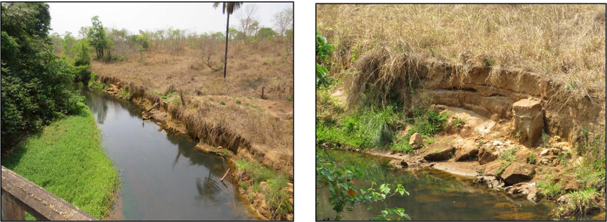
Figura 50: Fotos do Rio das Pedras na GO-431: à esquerda, a montante da ponte; à direita, detalhe do solapamento das bordas da foto anterior. Fonte: trabalho de campo de outubro de 2024.
