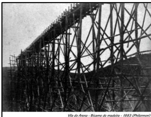
Figura 17: à esquerda, bicame de madeira; à direita, pilares para o rego d'água; imagens que ilustram as estruturas para o direcionamento e transposição das águas, na utilização do desmonte hidráulico das Minas do Abade. Fonte: https://pirenopolis.tur.br/cultura/historia/as-lavras-do-abade
