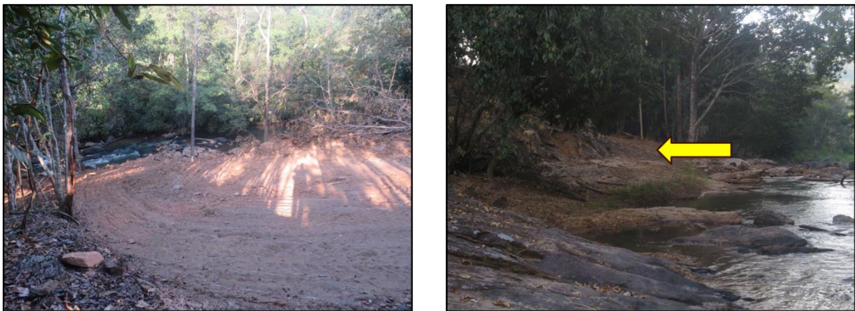
Figura 60: à esquerda, rampa de acesso feita por trator; à direita, localização da rampa vista da calha do rio. Fonte: trabalho de campo realizado em 2022.
