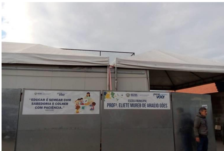
Figura 8 - Escola municipal em Búzios (RJ) funciona em estrutura de contêiner de forma emergencial. Disponível em: https://www1.folha.uol.com.br/educacao/2023/05/professores-apontam-falta-de-estrutura-e-de-recursos-em-escolas-publicas-do-pais.shtml . Acessado em 12 de dez. 2024.
