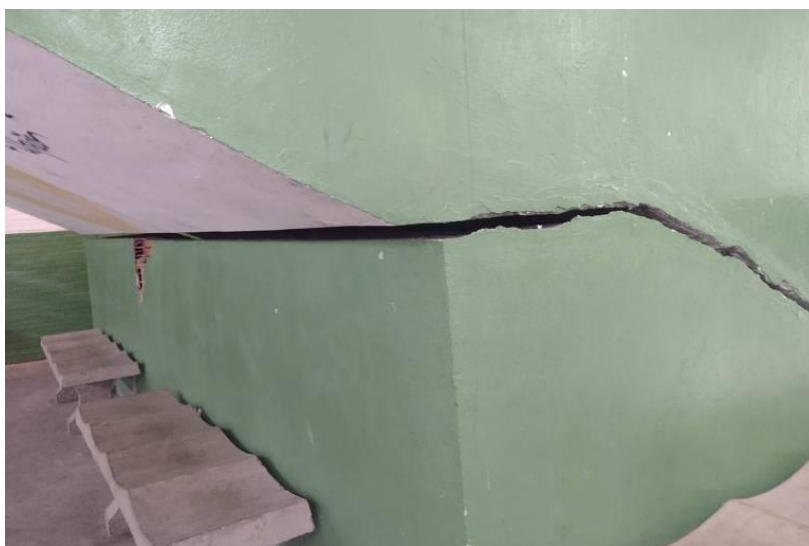
Figura 7 - Pátio da escola estadual Alarico Silveira, na região central de São Paulo, que teve de ser interditada em novembro de 2022 após obras serem adiadas por dois anos; a previsão é que sejam concluídas até o fim de 2023. Disponível em: https://www1.folha.uol.com.br/educacao/2023/05/professores-apontam-falta-de-estrutura-e-de-recursos-em-escolas-publicas-do-pais.shtml . Acessado em 12 de dez. 2024.
