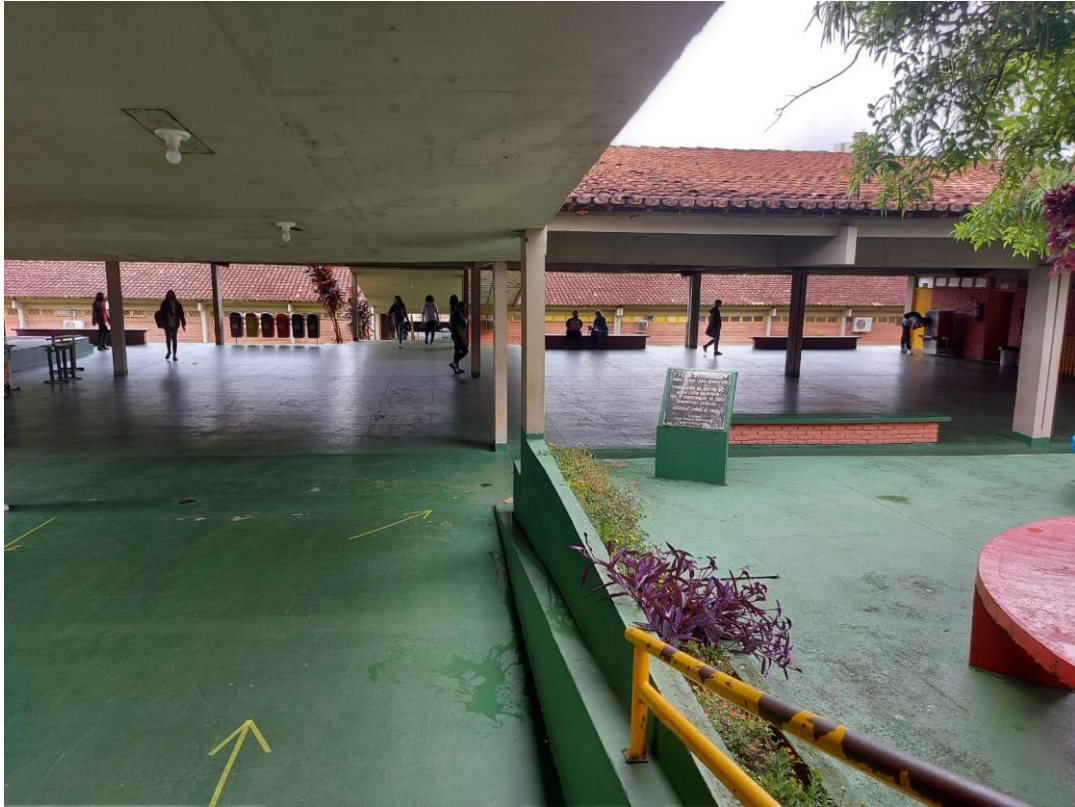
Figura 10 – Área interna do Colégio Estadual Polivalente Frei João Batista.
