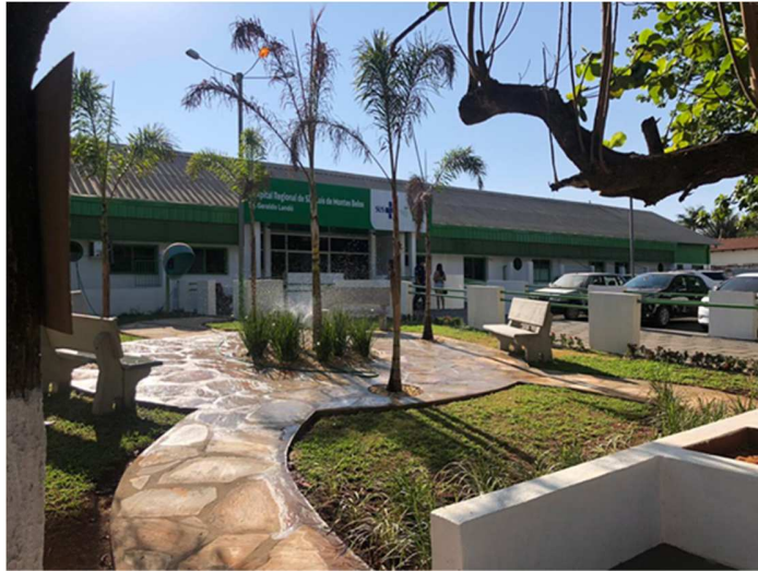
Figura 2 - Hospital Regional de São Luís de Montes Belos
