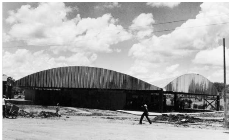
Figura 6 - Terminal Rodoviário sendo construído em 1970 Fonte: Acervo particular de Erly Barbosa
