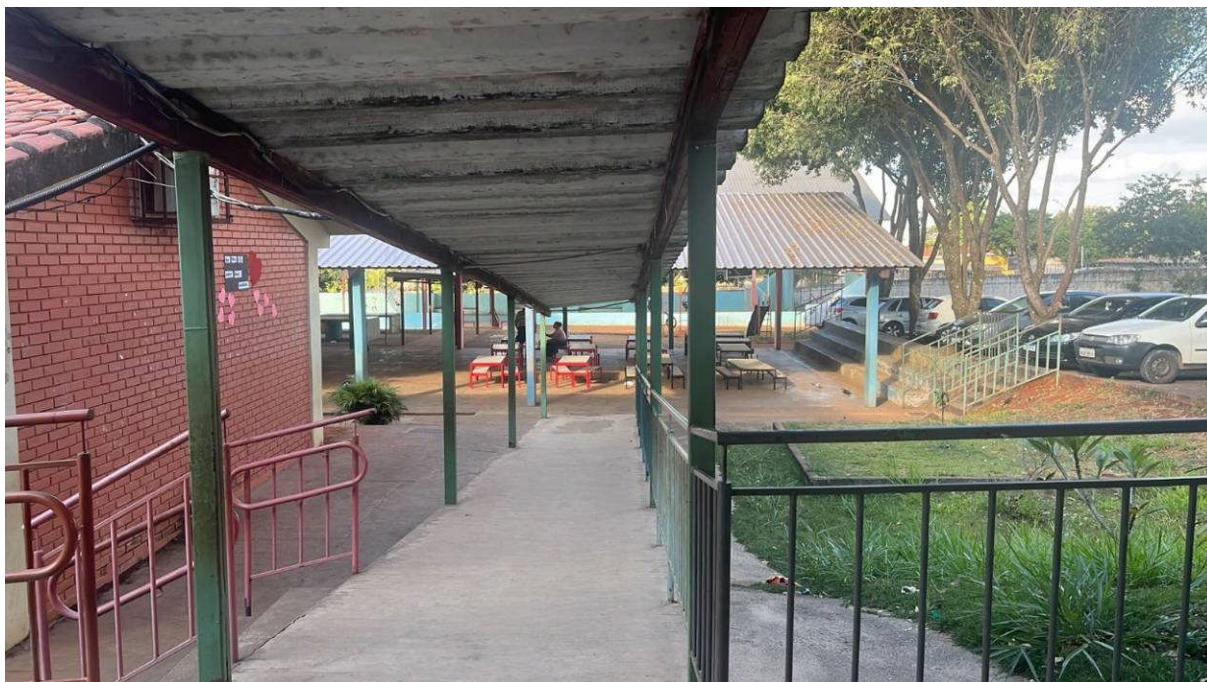
RAMPA DE ACESSO AO REFEITÓRIO ABERTO
