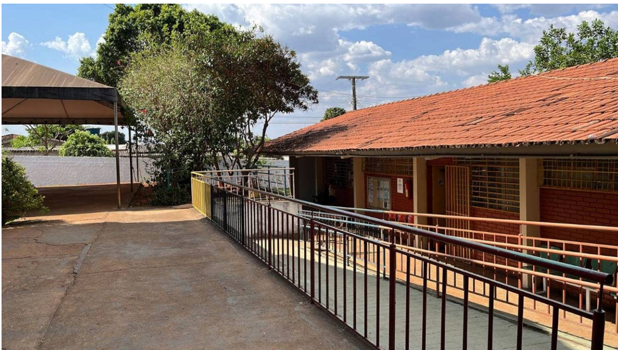
ACESSO AO PÁTIO – TENDA
