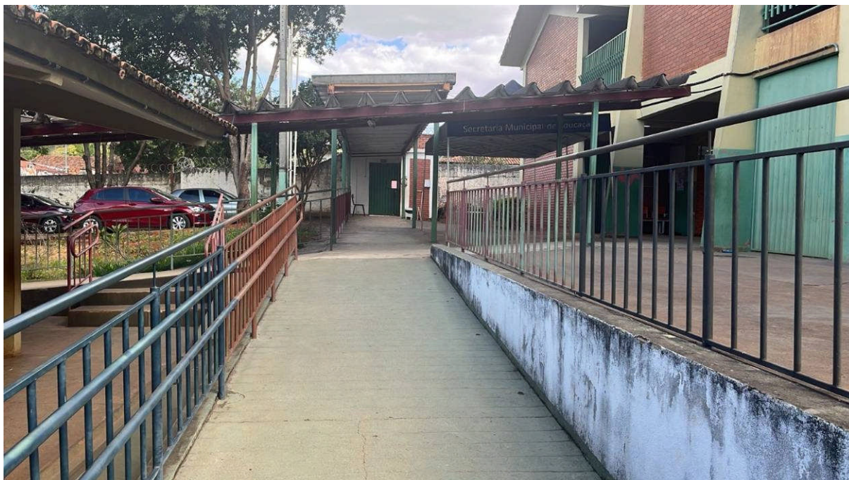
RAMPA DE ACESSO – BLOCO ADMINISTRATIVO PORTAO DE ENTRADA E SAIDA
