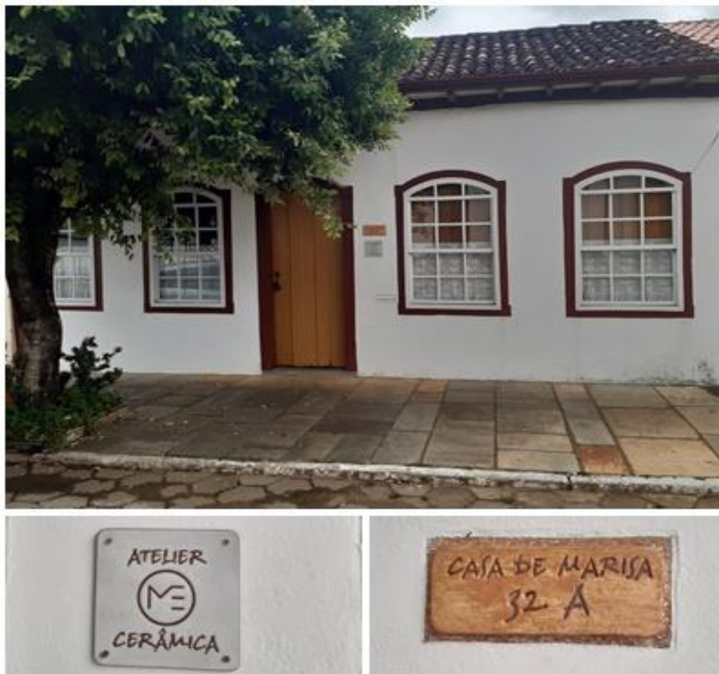
Figura 22: Casa na Rua Direita e detalhes da fachada do imóvel
