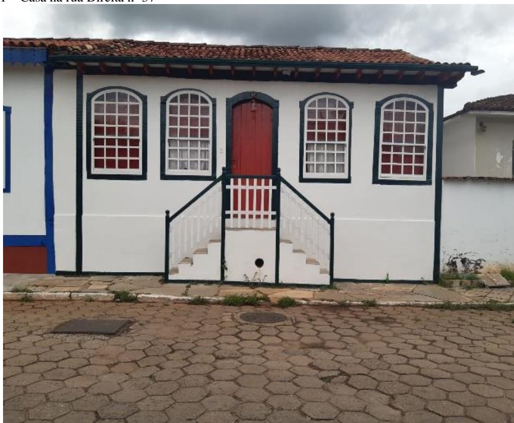
Figura 21 – Casa na rua Direita nº 37
