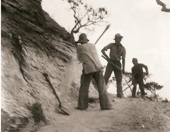
Ilustração 69 - Construção da estrada
