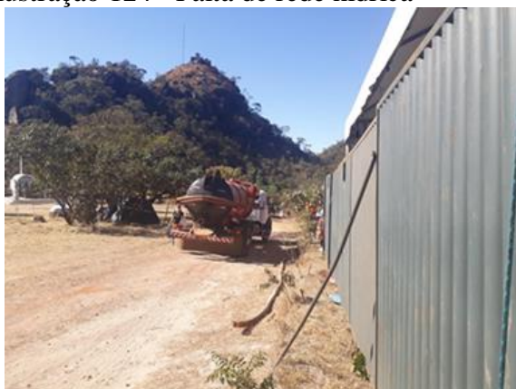
Ilustração 124 - Falta de rede hídrica
