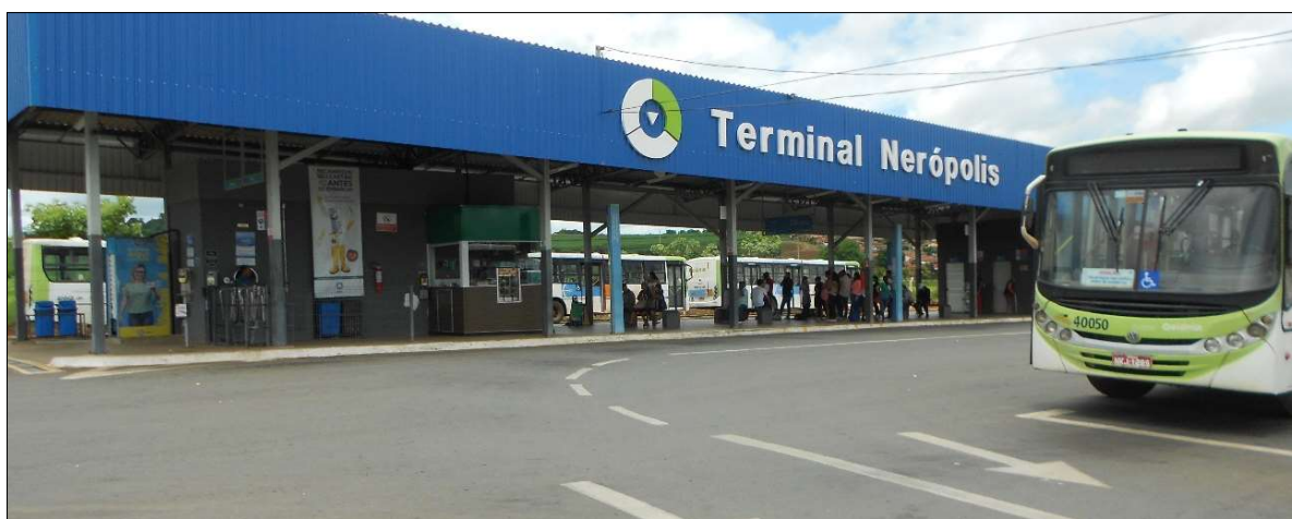
Ilustração 54 - Terminal rodoviário de Nerópolis (2020)
