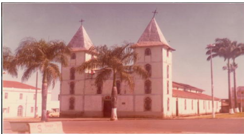
Figura 7: Igreja Matriz em alvenaria
