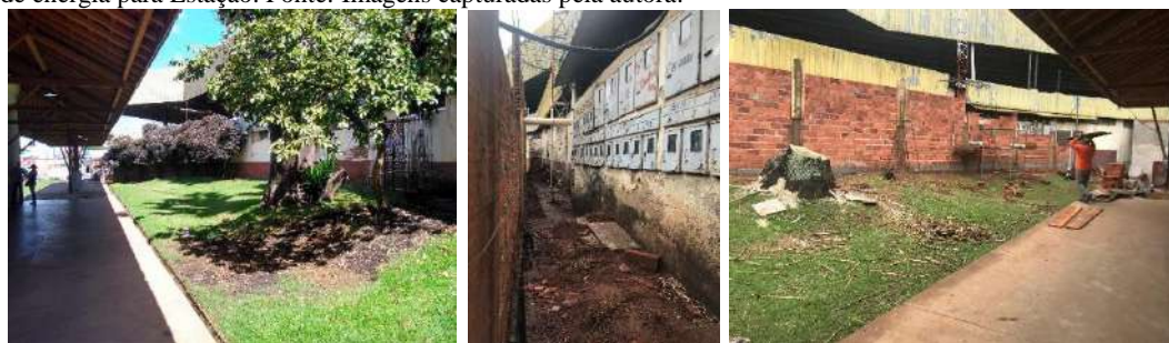
Figura 188: Área posterior da Estação, onde se pretendia criar o painel histórico. Fonte: Secretaria de Obras. Figuras 189 e 190: Obras de construção da muro escondendo os medidores de energia. Fonte: Imagens capturadas pela autora.
