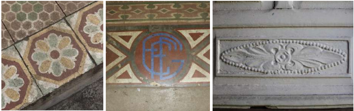
Figura 93: Detalhe de ladrilho hidráulico no hall de embarque. Figura 94: Soleira decorada com as iniciais da “Estrada de Ferro Goyaz”. Figura 95: Detalhe de almofadas decoradas das portas. Fonte: FARSETTE, 2013.
