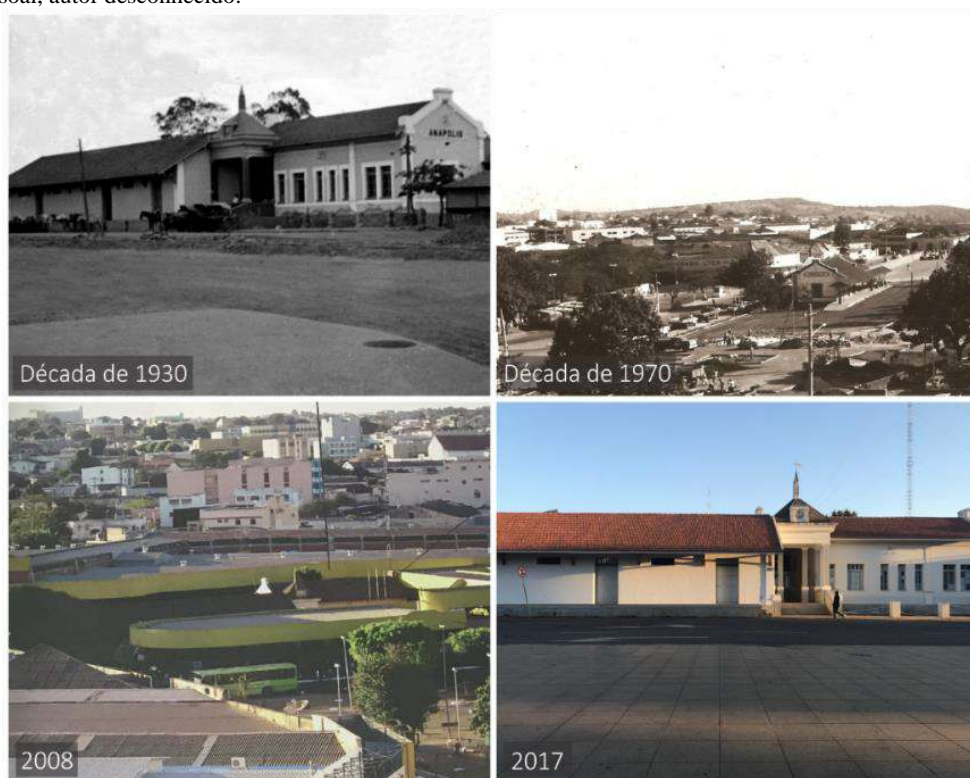
Figuras 101 e 102: Fotos antigas do Estação. Fonte: Museu Histórico de Anápolis. Figura 103: Estação encoberta pelo terminal. Fonte: Processo Judicial 200902883814. Figura 104: Estação após a retirada do terminal. Fonte: Imagem capturada pela autora.
