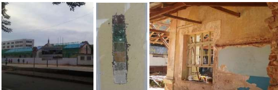
Figuras 147, 148, 149, 150, 151, 152 e 153: Obras de restauro do prédio da Estação. Fonte: Museu Histórico de Anápolis.
