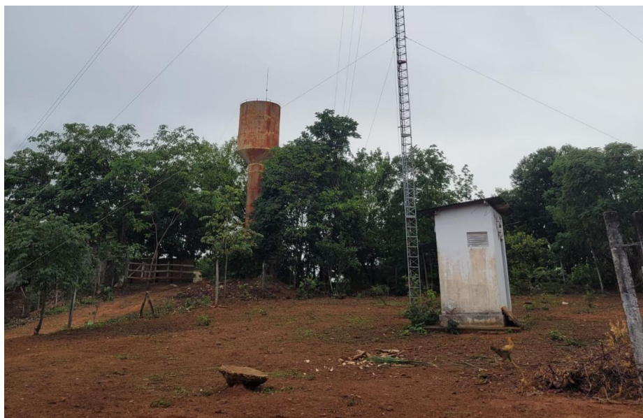
Figura 13 – Caixa d'água no Povoado da Capela do Rio do Peixe administrada pela Prefeitura Municipal de Pirenópolis/GO
