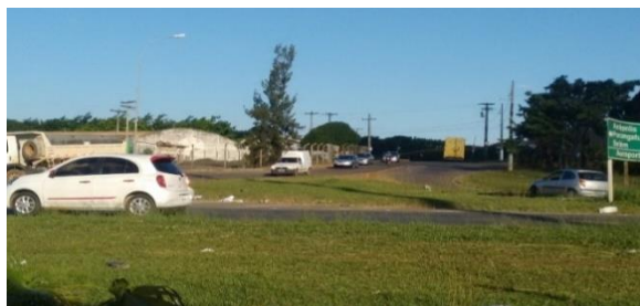
Imagem 34: Rotatória de encontro entre a BR-153 e a Av. Juscelino Kubitschek/saída da rotatória pela Rua Francisco Valoz, Anápolis/GO, 2019.
