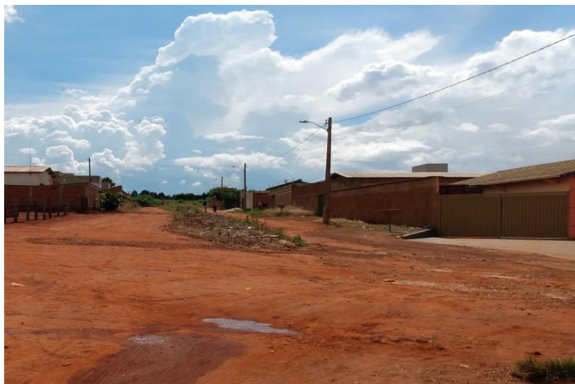
Imagem 25: Onde não chega a estrutura: foto da parte sem asfalto do bairro da Lapa, Anápolis-GO.
