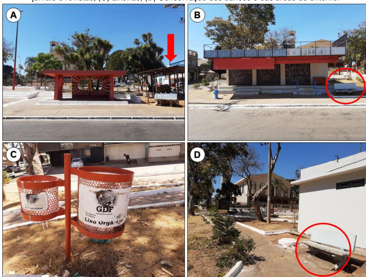
Figura 15 – Condições físicas/estruturais e equipamentos urbanos presentes na Praça Padre Antônio Marcigaglia: (A) Parada de ônibus e barraca de lanches em destaque; (B) Antiga banca de jornais e revistas; (C) Lixeiras; (D) Conservação dos bancos e das áreas de entorno.
