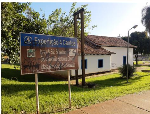
Figura 24 – Pichação na placa de identificação.
