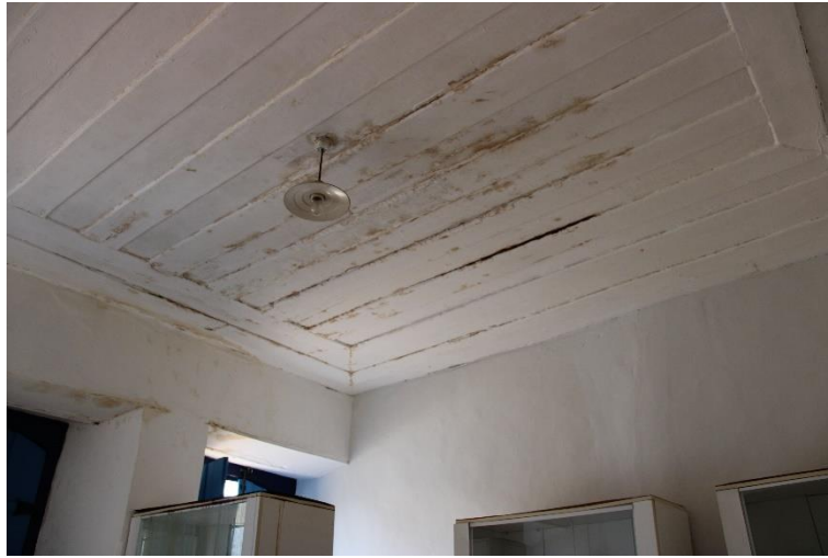
Figura 33 - Forro de cômodo da Igreja de Nossa Senhora da Abadia
