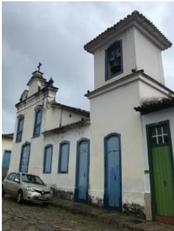
Figura 25 - Torre sineira da Igreja de Nossa Senhora da Abadia
