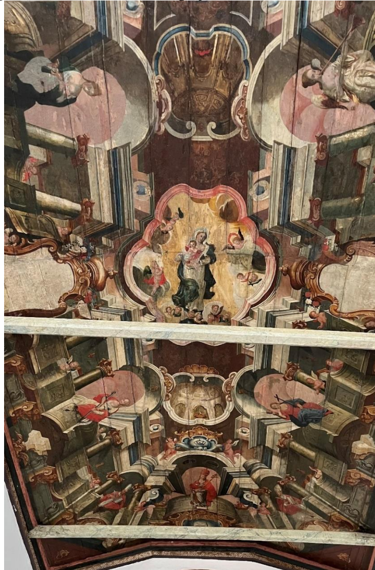
Figura 29 - Forro da nave da Igreja de Nossa Senhora da Abadia
