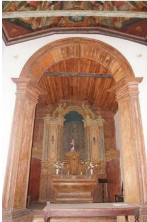
Figura 26 - Interior da Igreja de Nossa Senhora da Abadia
