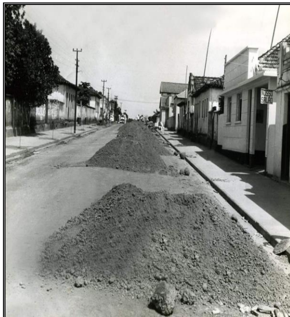
Figura 65: Foto da construção da rua Major Vítor (Rua do Banco Itaú)/1960.
