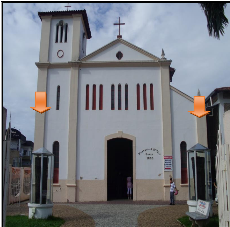
Figura 15: Foto da Capela Nossa Senhora das Dores com destaques nos invólucros de vidro com as madeiras retiradas na última reforma em 2010.
