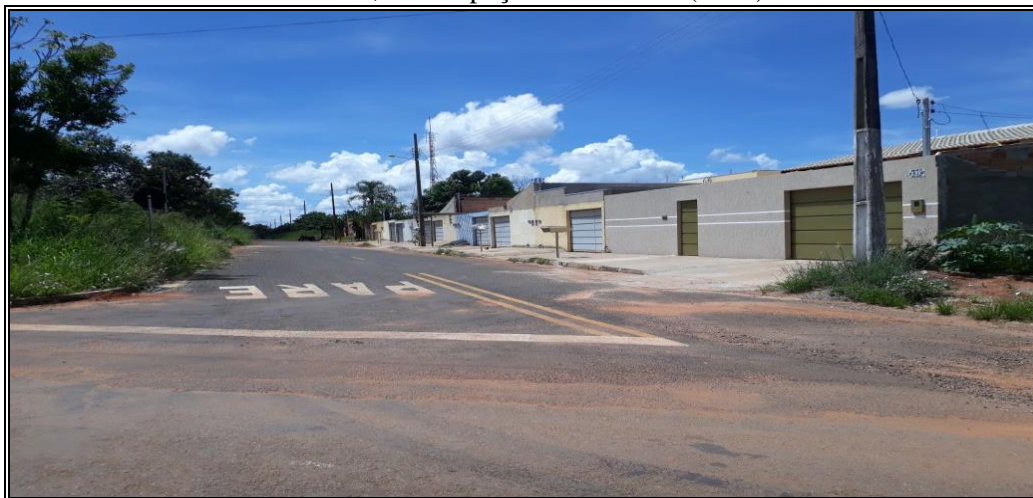
Figura 83: Vista do loteamento “Mansões Recanto da Serra”, bairro Recanto da Serra em Caldas Novas e uma das ruas perpendiculares a Avenida que se encontra o Santuário Nossa Senhora da Salete, seus espaços e territórios (2018)
