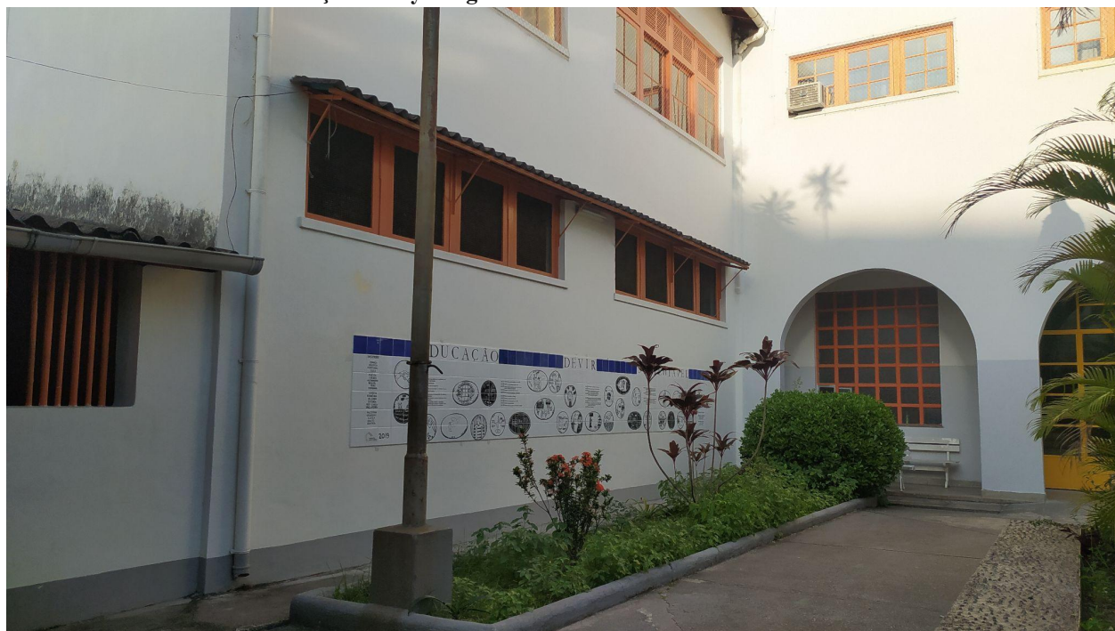
Foto 09: Pátio da Escola Fundação Darcy Vargas
