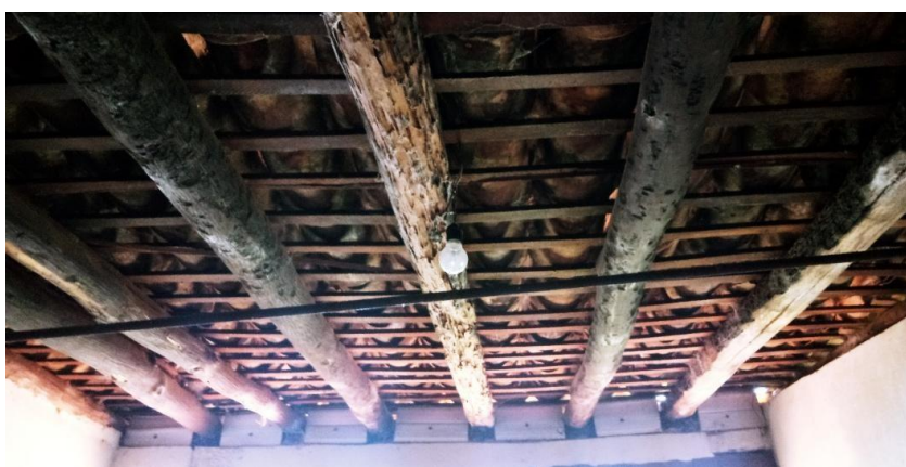
Imagem 49: Detalhe interior do madeiramento da cobertura da cozinha. Fonte: acervo do autor 2020.
