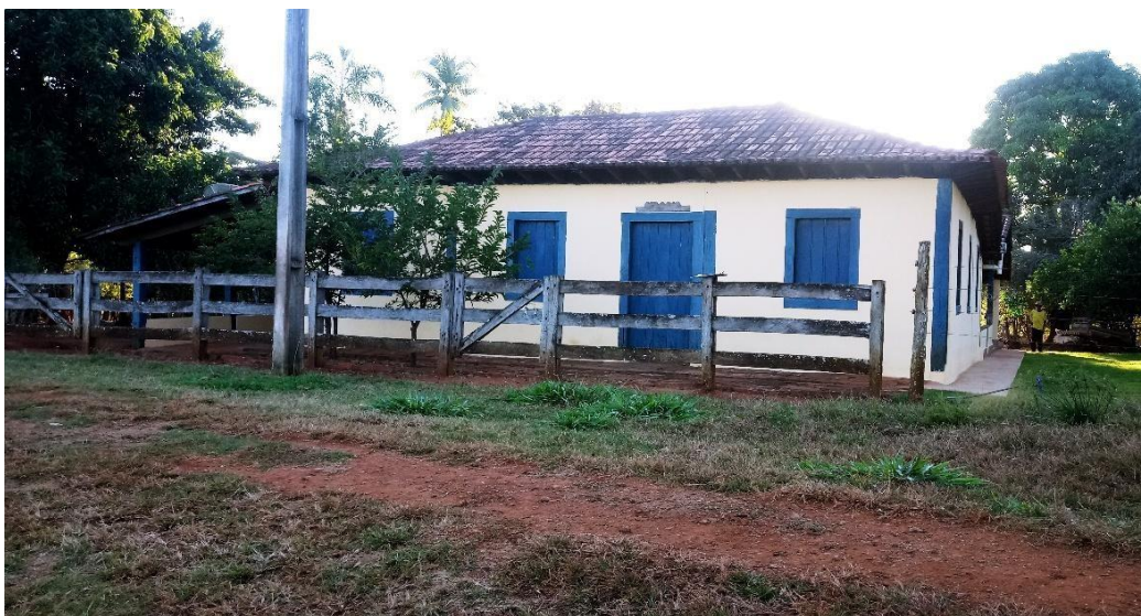
Imagem 9: Casa de fazenda, fachada principal. Fonte: acervo do autor 2020.
