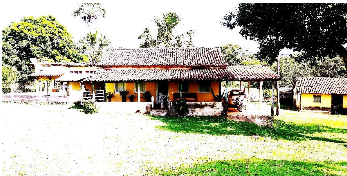
Imagem 45: Vista frontal da sede. Fonte: acervo do autor 2020.
