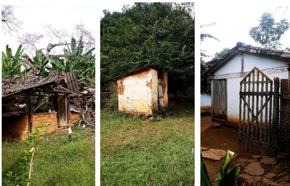
Imagem 42: Edifícios de apoio da sede. Da direita para a esquerda: O cômodo do Monjolo, o banheiro externo e o quarto de serviço. Fonte: acervo do autor 2020.
