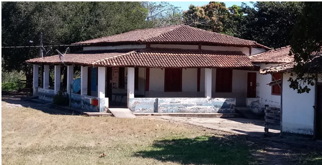
Imagem 53: Vista do edifício principal pela estrada de acesso. Fonte: acervo do autor 2020.
