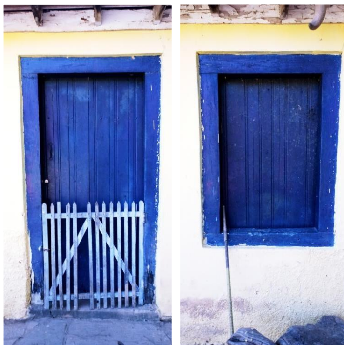
Imagem 23: Detalhe da porta e janela em madeira. Fachada frontal da sede. Fonte: acervo do autor 2020.
