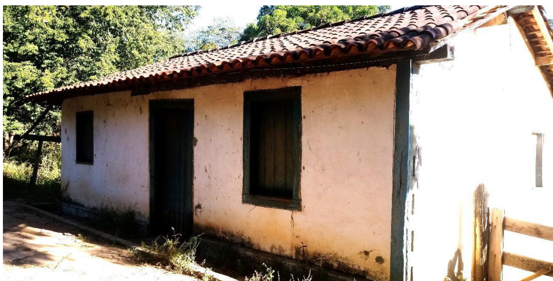
Imagem 10: Casa de fazenda, fachada principal. Fonte: acervo do autor 2020.
