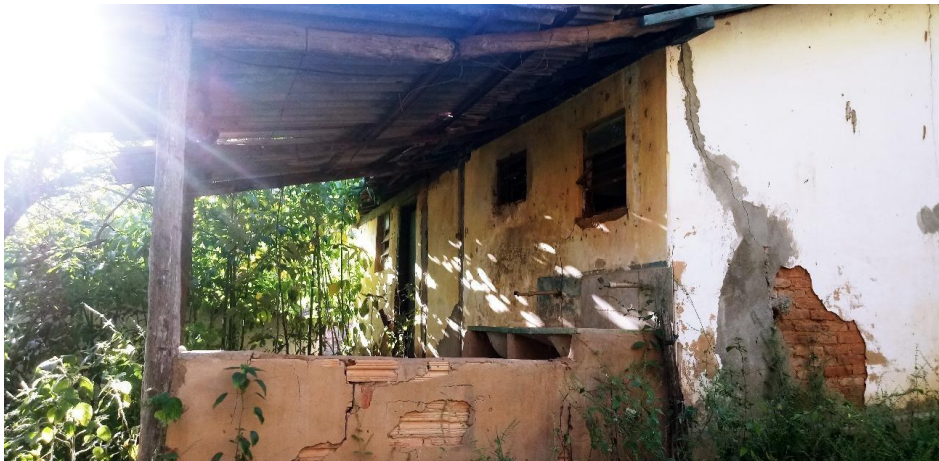
Imagem 14: Casa de fazenda, vista dos fundos. Fonte: acervo do autor 2020.
