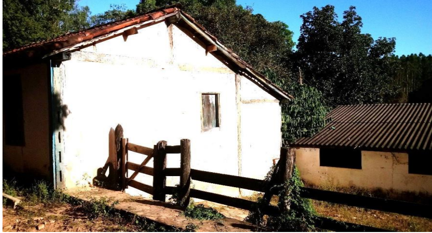
Imagem 11: Casa de fazenda, fachada lateral e estábulo. Fonte: acervo do autor
