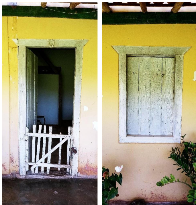
Imagem 52: Detalhe das aberturas do edifício sede. Percebe-se um detalhe de chanfrado na verga. Fonte: acervo do autor 2020.
