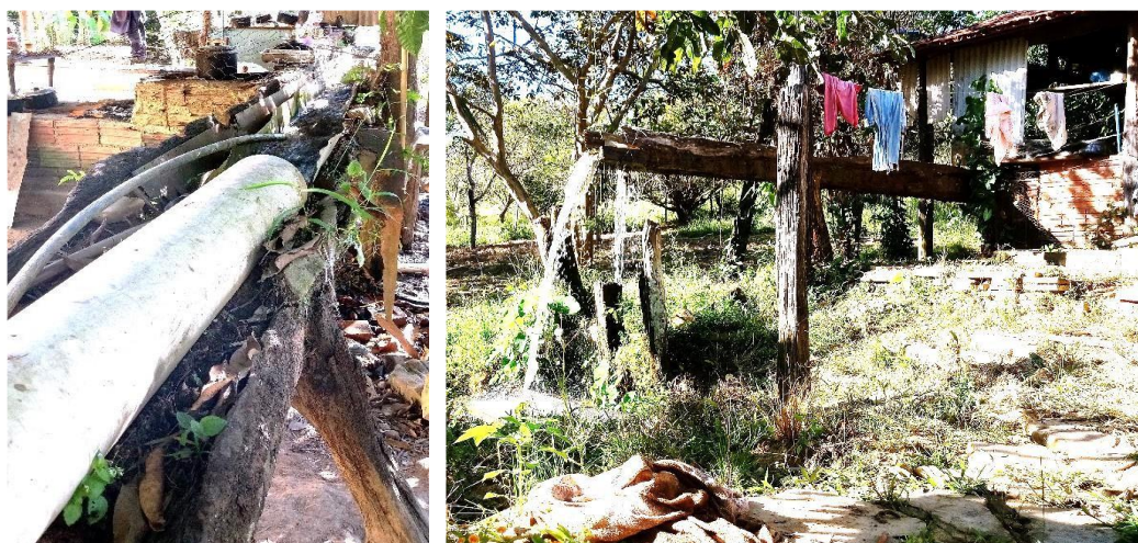
Imagem 19: Rego d'água canalizado sobre bica de aroeira. Fonte: acervo do autor 2020.
