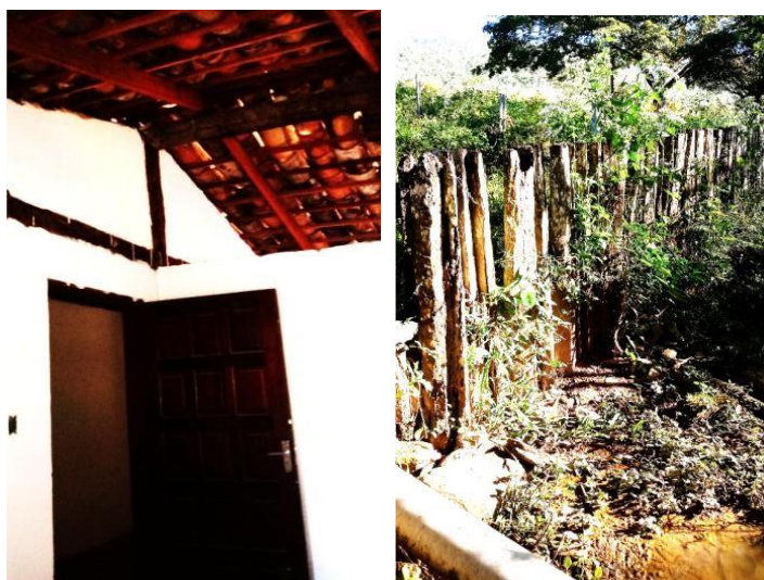
Imagem 22: Detalhe do fechamento interno da casa em meia parede (esq) e cercado do quintal em lasca de aroeira em pé (dir). Fonte: acervo do autor 2020.
