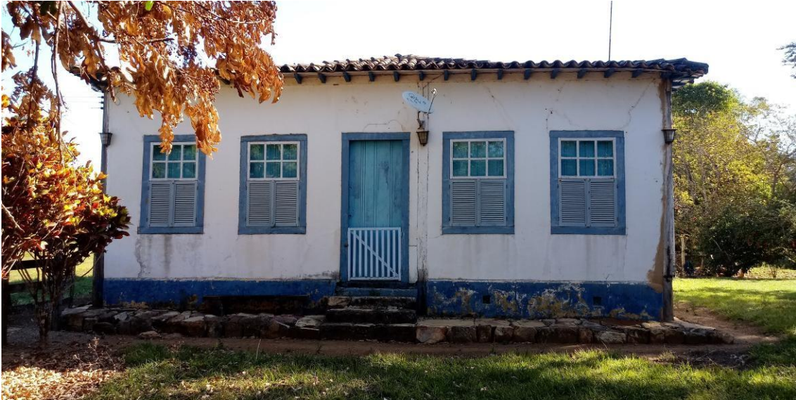
Imagem 62: Vista lateral do edifício da casa sede. Fonte: acervo do autor 2020.
