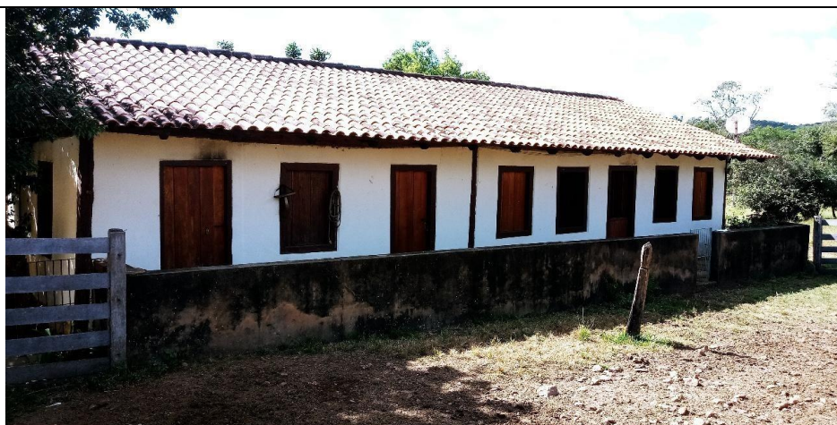
Imagem 29: Vista frontal da sede. Fonte: acervo do autor 2020.
