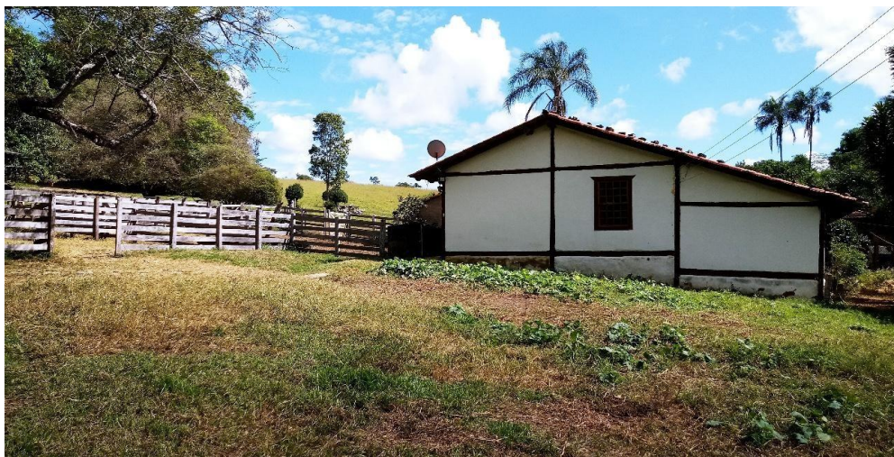
Imagem 32: Vista lateral da sede, sentido do acesso. Fonte: acervo do autor 2020.
