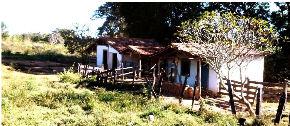
Imagem 18: Edifícios de apoio. Fonte: acervo do autor 2020.
