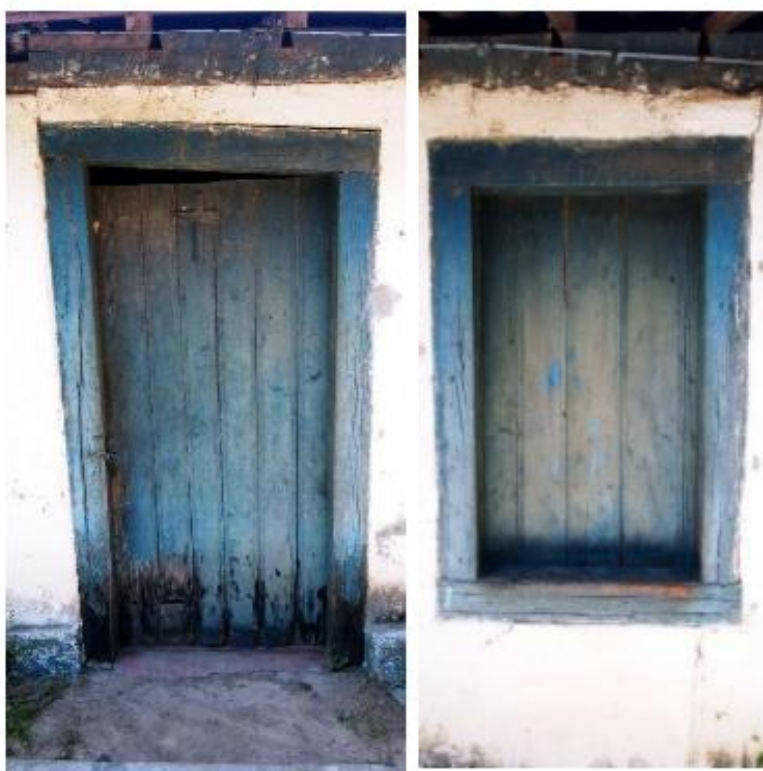
Imagem 15: Detalhe das esquadrias da Casa de fazenda, vista frontal. Fonte: acervo do autor 2020.
