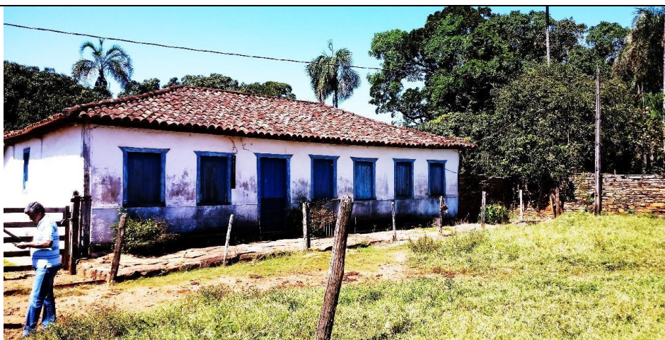
Imagem 24: Vista frontal da sede. Fonte: acervo do autor 2020.
