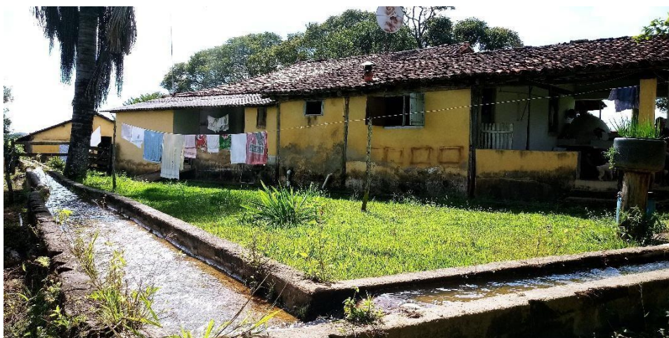
Imagem 47: Vista do rego em canal de alvenaria e fundo da sede. Fonte: acervo do autor 2020.
