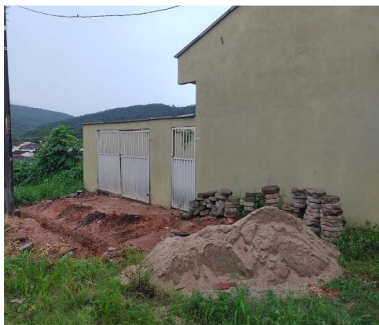
Foto 22: Construção de kitnets próximas da Área de Proteção Permanente (APP)
