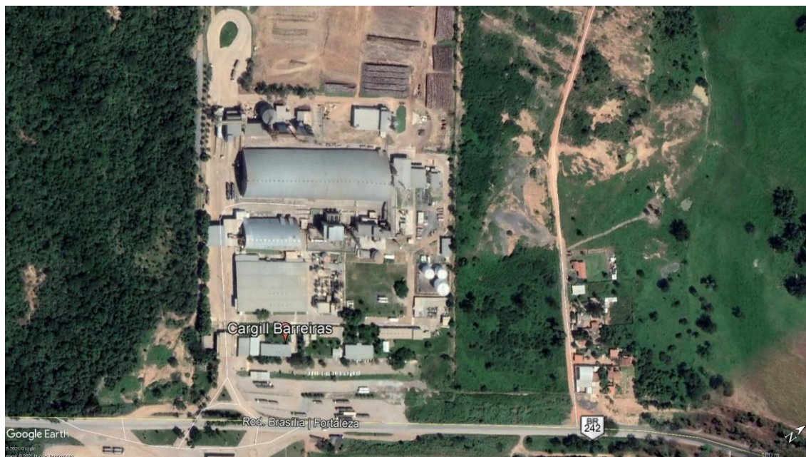
Figura 14 - Vista aérea Cargill em Barreiras
