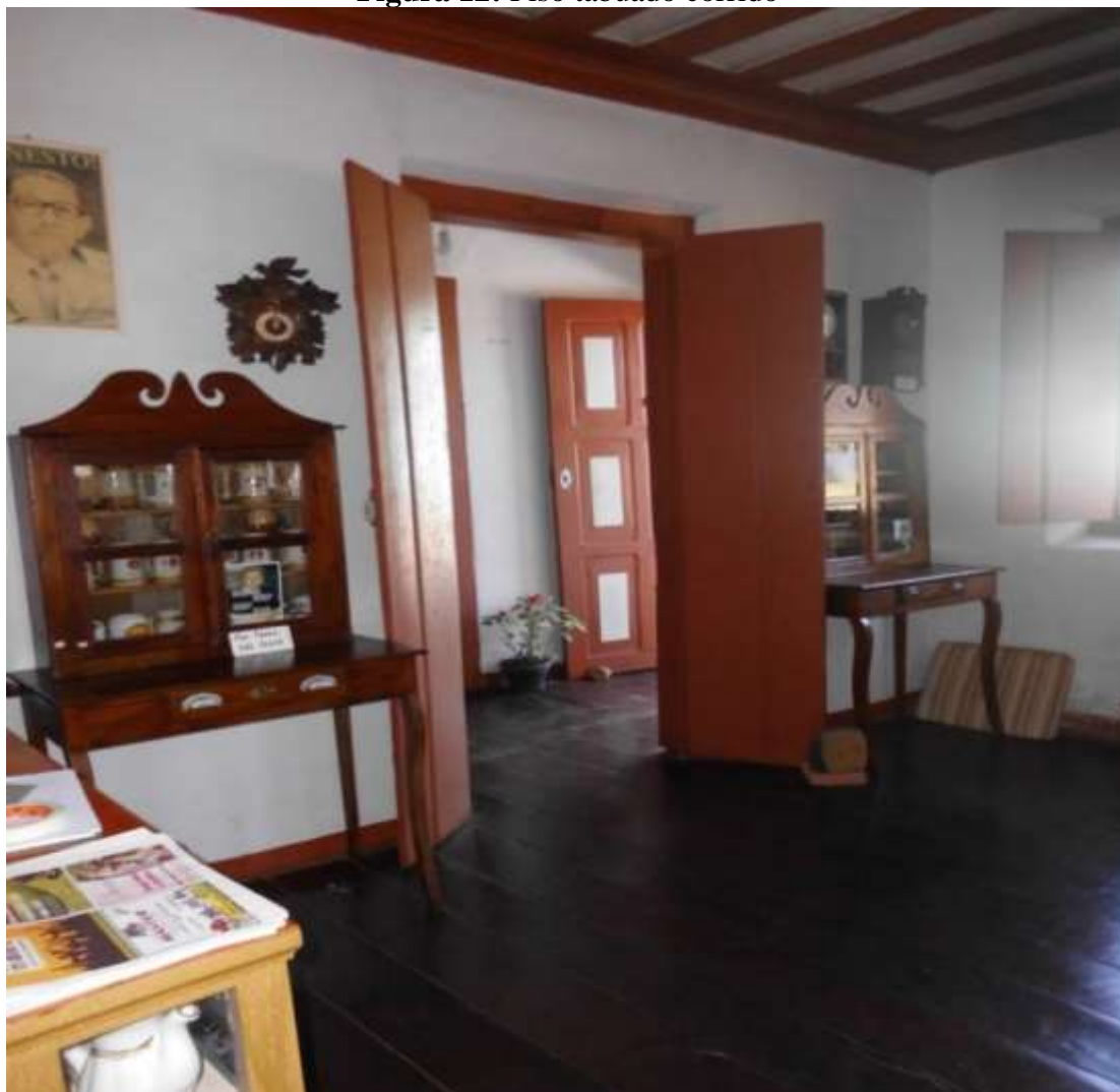
Figura 12: Piso tabuado corrido
