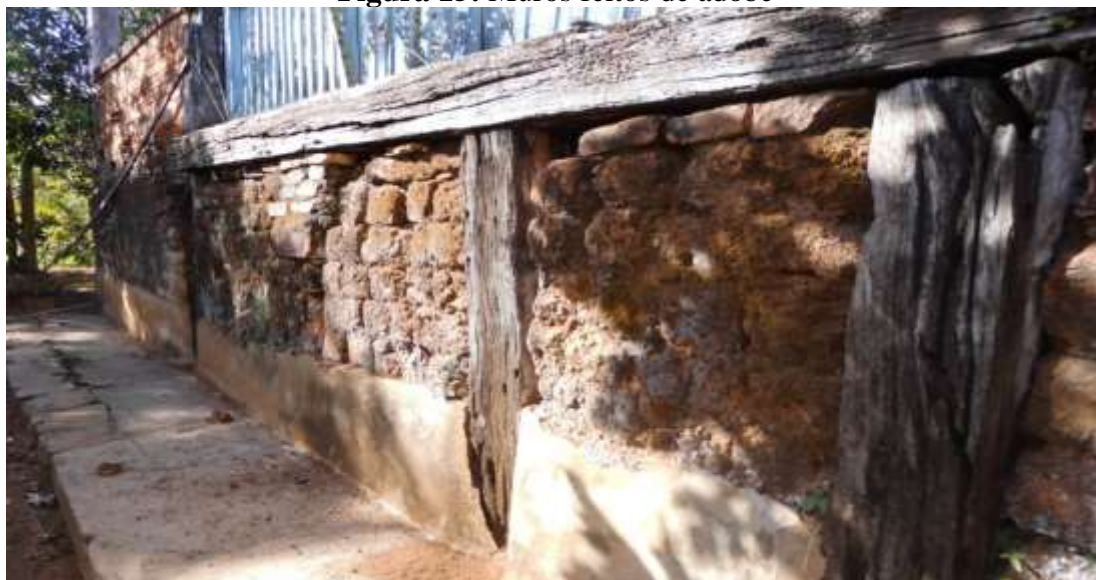
Figura 15: Muros feitos de adobe
