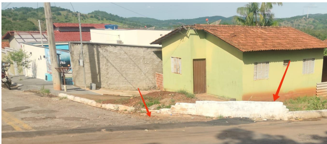
Fotografia 60 - Improvisos na engenharia urbana
