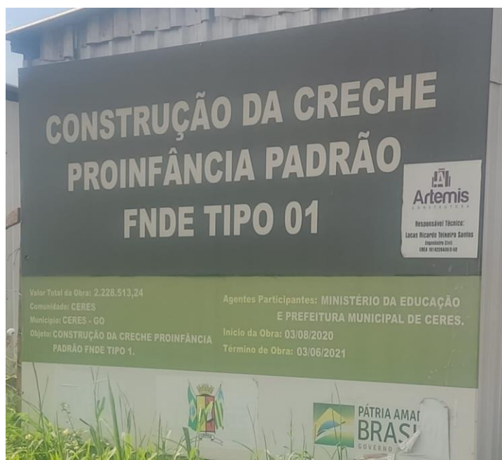
Fotografia 56 – Construção da creche no Conjunto Bernardo Sayão
