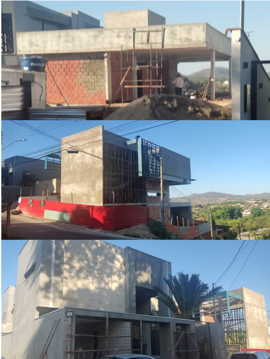
Fotografia 13 – Casas em construção no Setor Bela Vista
