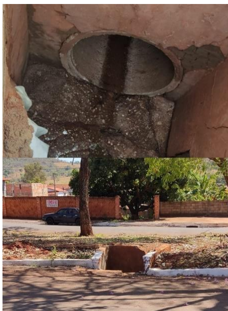
Fotografia 52 - Bueiro/canal de drenagem do manancial/galeria pluvial 116
