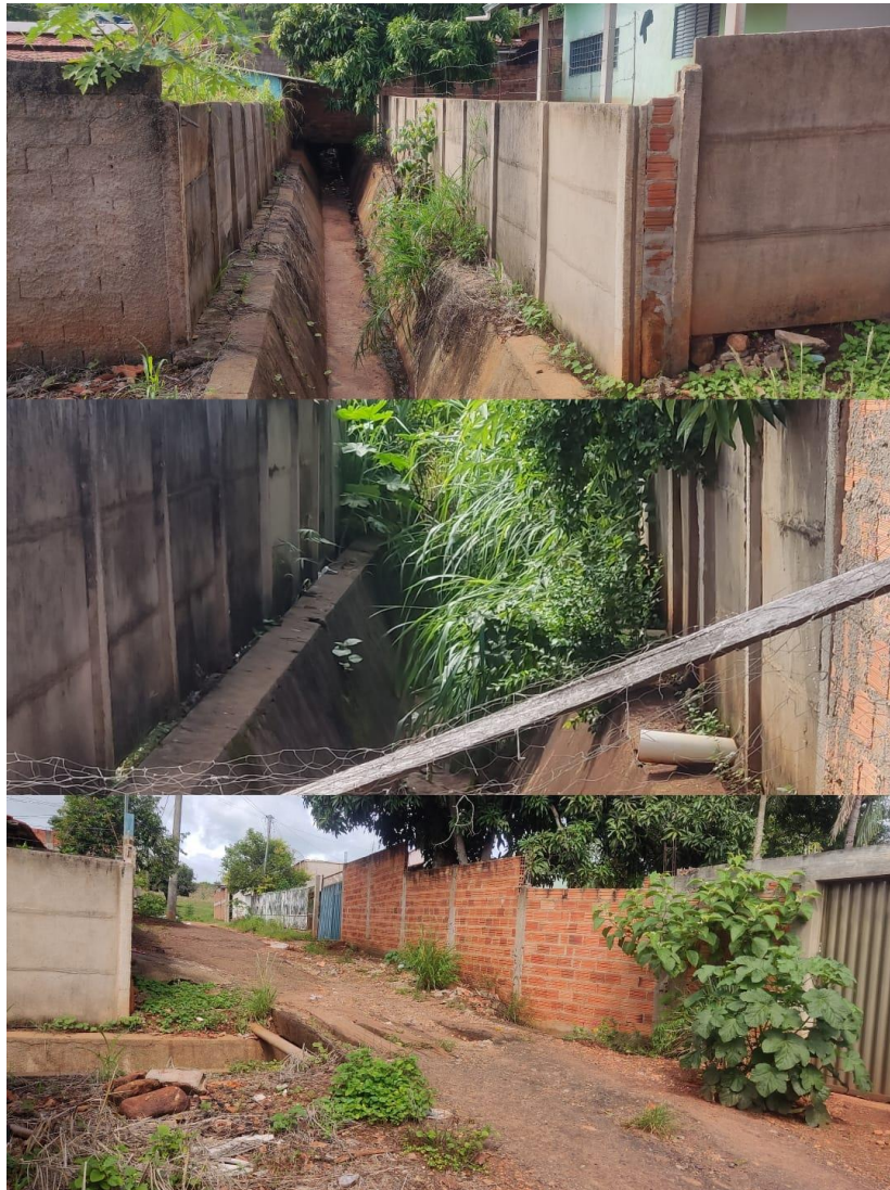
Fotografia 39 - Inadequação ambiental da área invadida na Vila São Patrício
