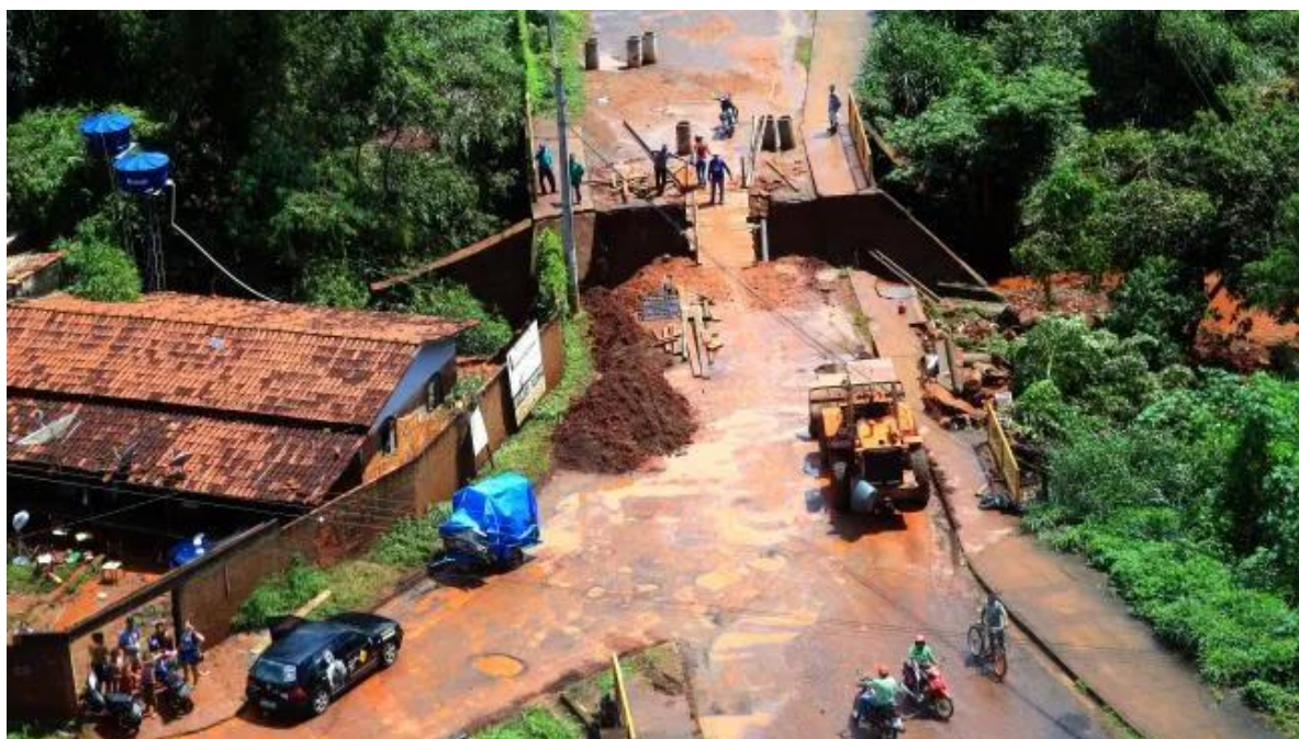
Fotografia 34 - Estragos causados pela enchente do Córrego Água Limpa e do Rio das Almas na Vila Pedrosa em Ceres-GO
