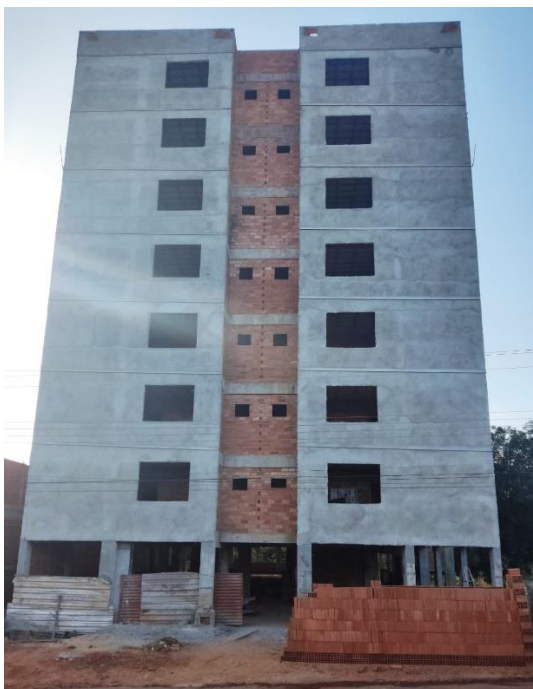
Fotografia 19 - Construção predial habitacional, na Avenida Bernardo Sayão, Quadra Industrial, Lote 221
