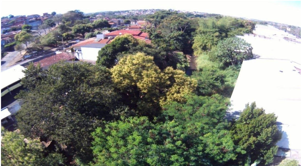
Fotografia 16 - Córrego Água Limpa e sua APP indevidamente ocupada por casas e edificações prediais comerciais
