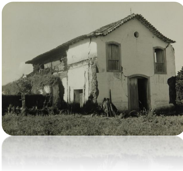
Fonte: Arquivo DPHAN. Monumento Igreja Pilar (Capela). Localização: Itaiú (ex- Ouro Fino). Ano: 1952.
