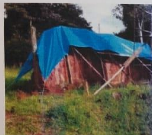
Fig.2 Falta de peças de distribuição de cargas (tábuas) diferente do projeto proposto
