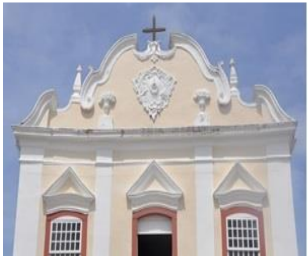
Imagem 9: Fachada da Igreja Nossa da Boa Morte. Foto: Fernando Santos (2017).
