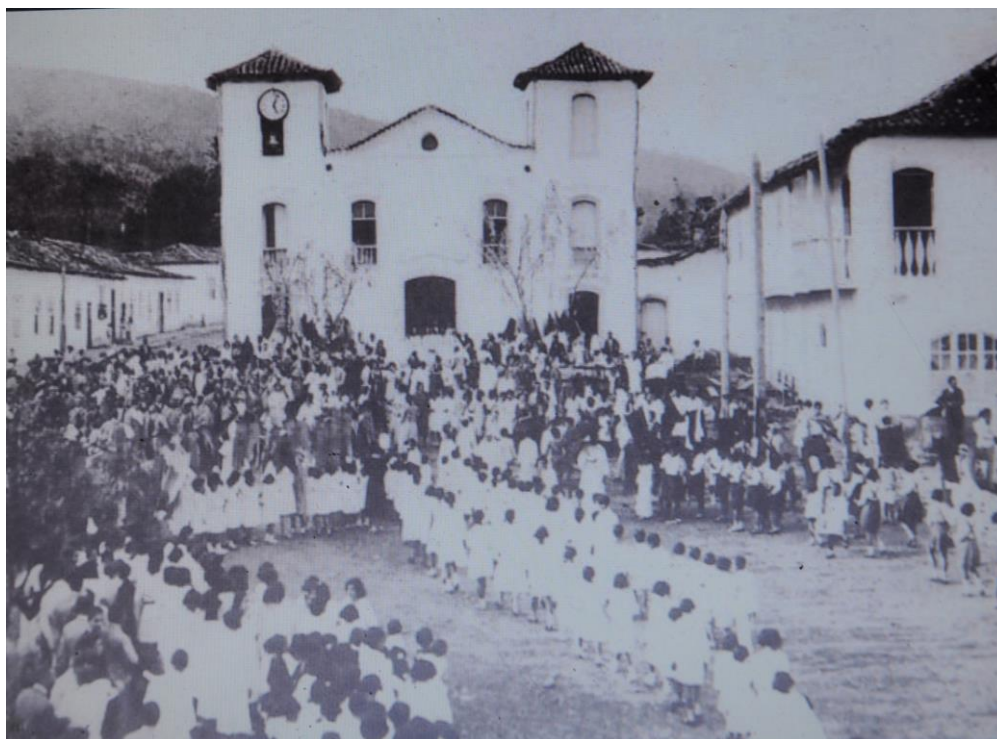
Imagem 4: Festa do Rosário na antiga Igreja Nossa Senhora do Rosário, Na Cidade de Goiás. Foto: J. Craveiro (apud TAMASO, 2007, p. 614).
