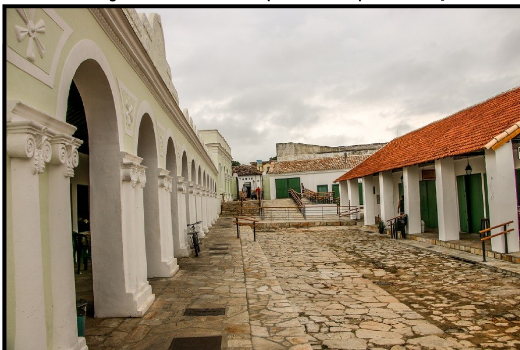
Figura 3 – Mercado municipal de Goiás após restauração
