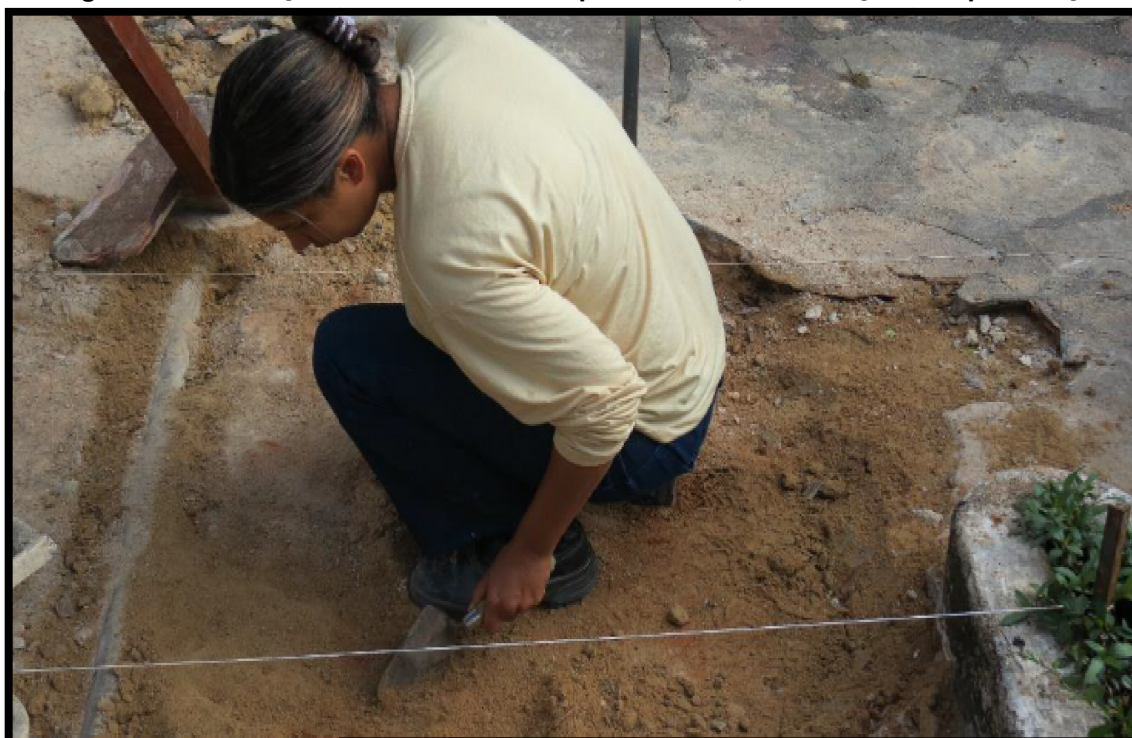
Figura 4 – Escavação no Mercado municipal de Goiás, restauração e requalificação.
