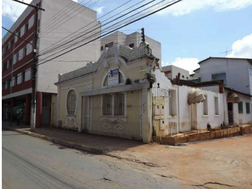
Figura 53: Antigo edifício sendo demolido permanecendo apenas a fachada em 2013.
