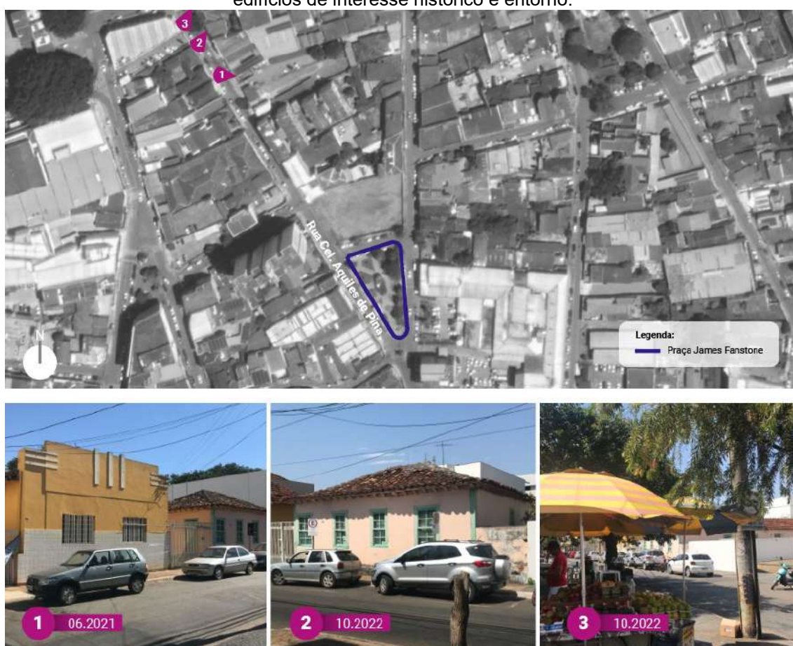
Figura 83: Mapa com a localização da Rua Cel. Aquiles de Pina e fotografias que mostram edifícios de interesse histórico e entorno.
