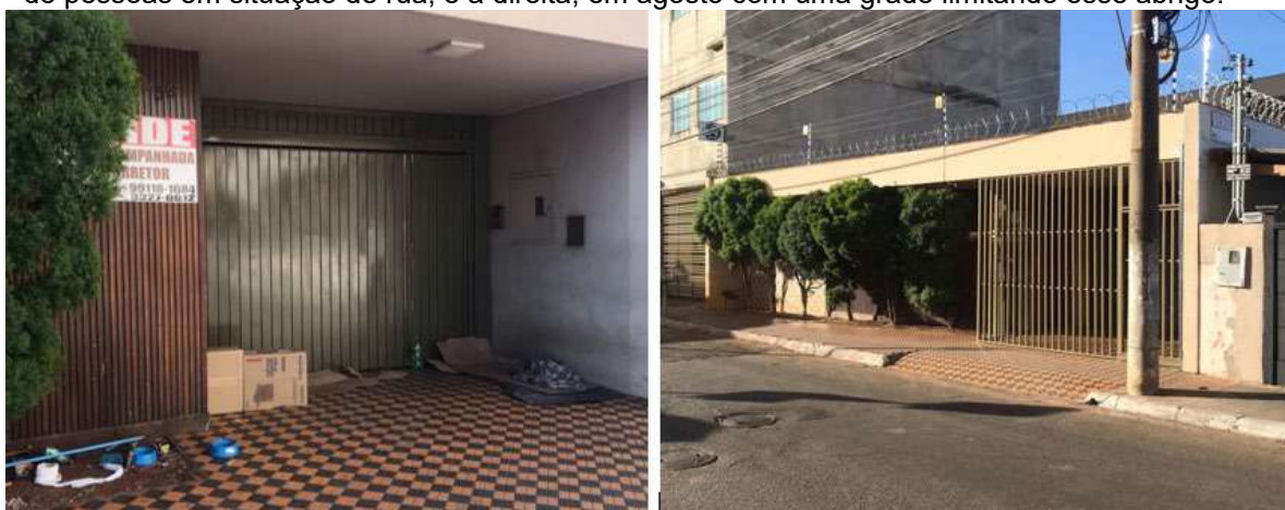
Figura 79: Calçada da casa modernista, à esquerda em junho com itens que mostram abrigo de pessoas em situação de rua; e à direita, em agosto com uma grade limitando esse abrigo.
