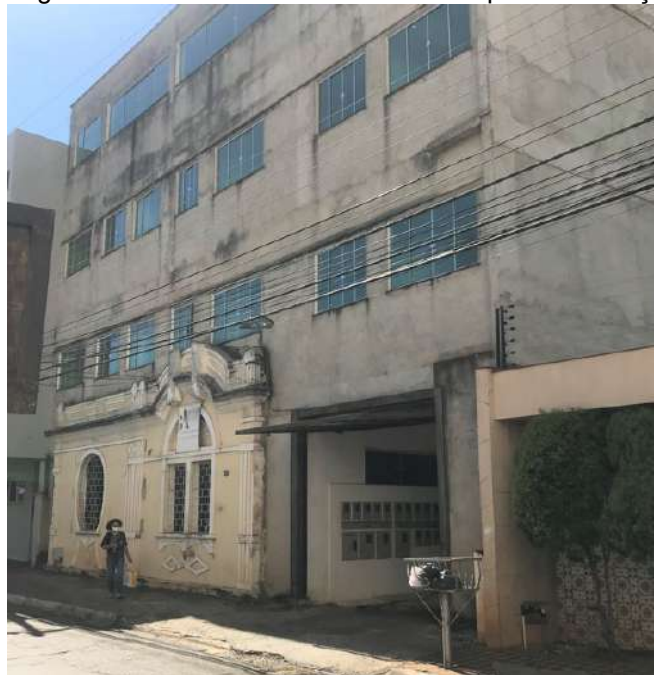
Figura 54: Antiga casa de José Fernandes Valente após a demolição, em 2021.
