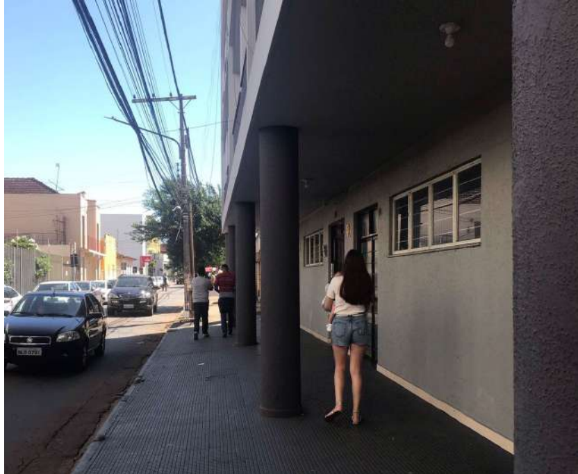
Figura 81: Calçada do Edifício José M. Vasconcelos.
