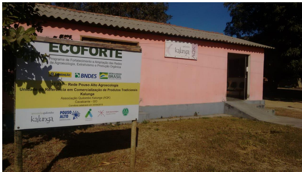
Figura 226 - Sede da Associação Quilombo Kalunga em Cavalcante
