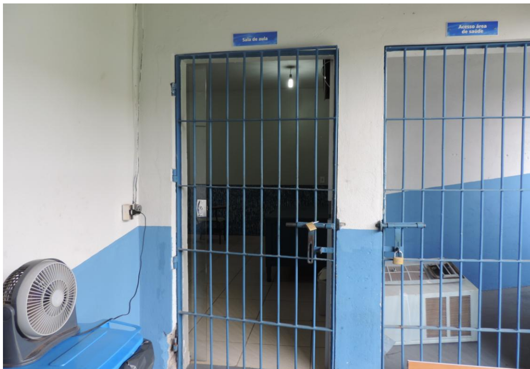
Figura 10 – Porta de entrada da sala, vista do lado de fora.
