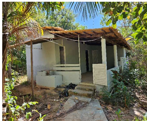
Figura 10 – Outra construção existente no local.
