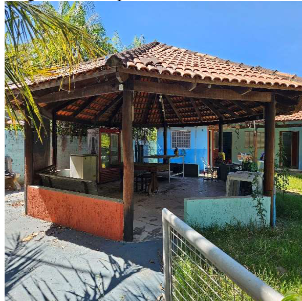
Figura 8 – Quiosque ocupando de forma irregular a área ripária do curso hídrico.
