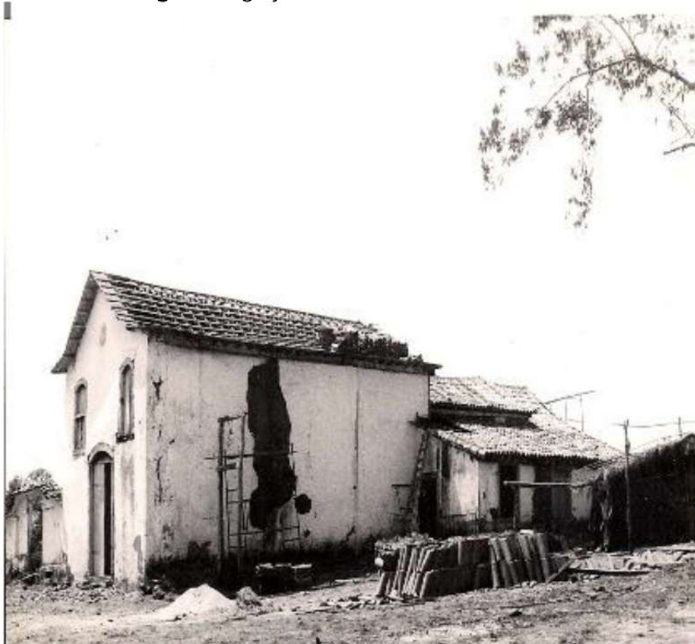
Figura 6. Igreja sendo reformada em 1993.
