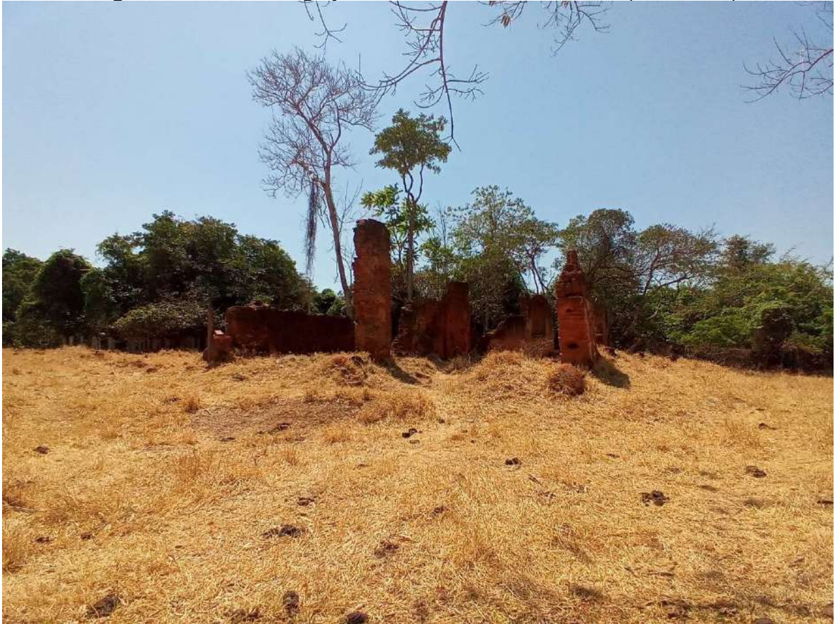
Figura 1. Ruínas da Igreja de Nossa Senhora do Pilar (Ouro Fino).
