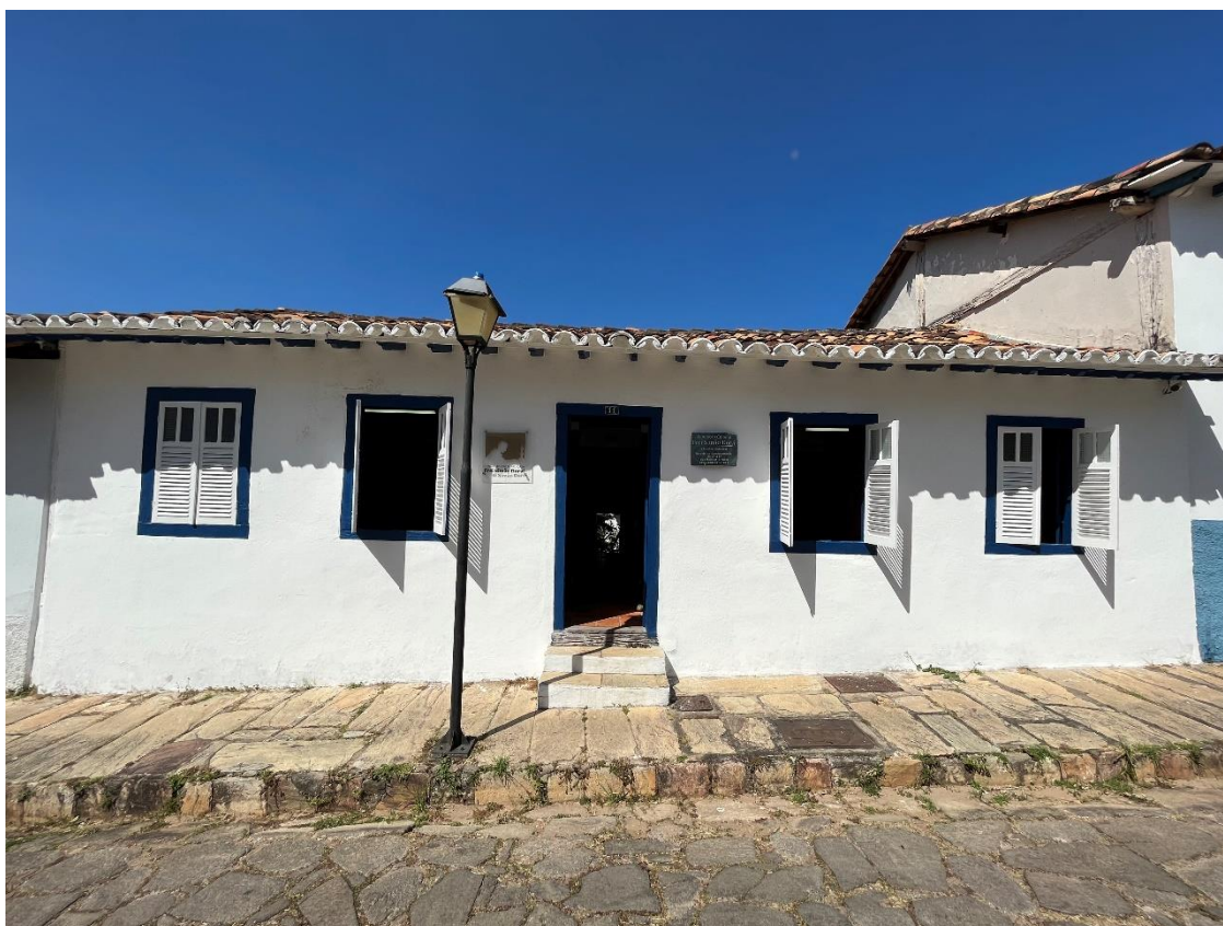
Figura 3: Fachada Frontal da Fundação Cultural Frei Simão Dorvi.
