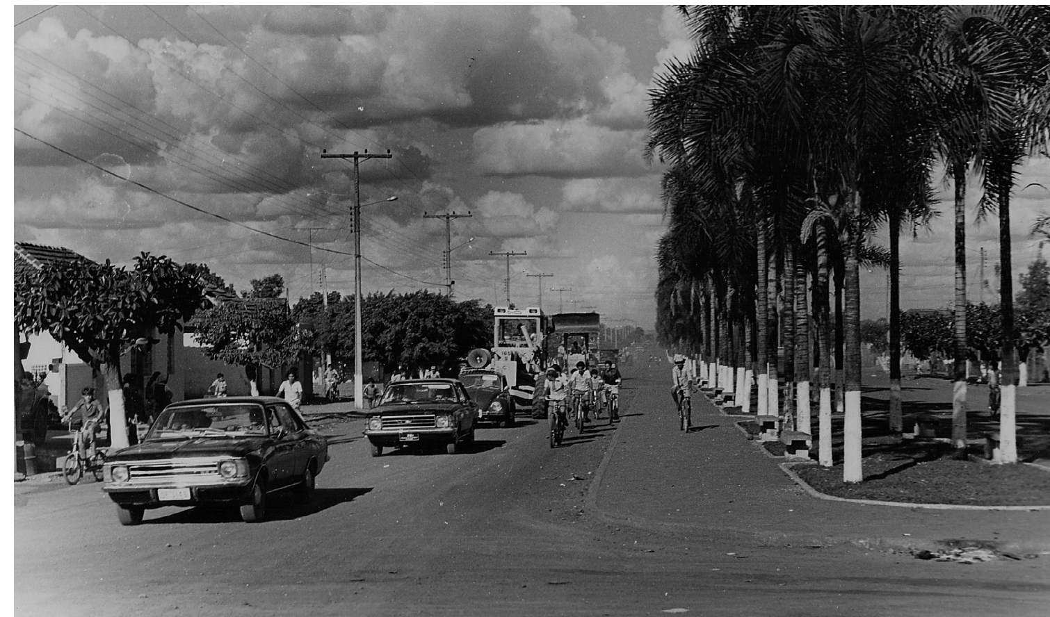
Desfile do maquinário do Plano JK, na avenida Goiânia, Firminópolis-GO. Fonte: IBGE, s.d.
