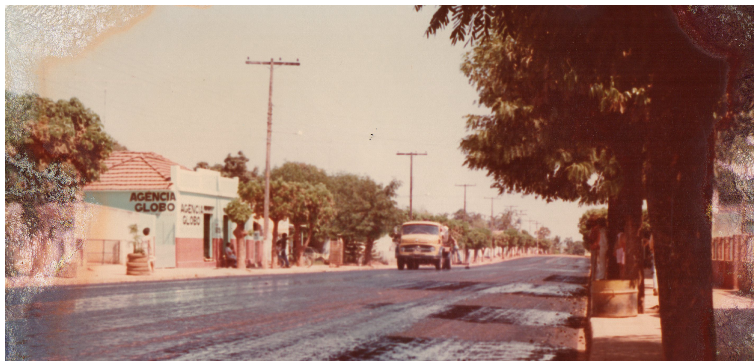
Chegada do asfalto em Firminópolis - GO. Fonte: IBGE, s.d.
