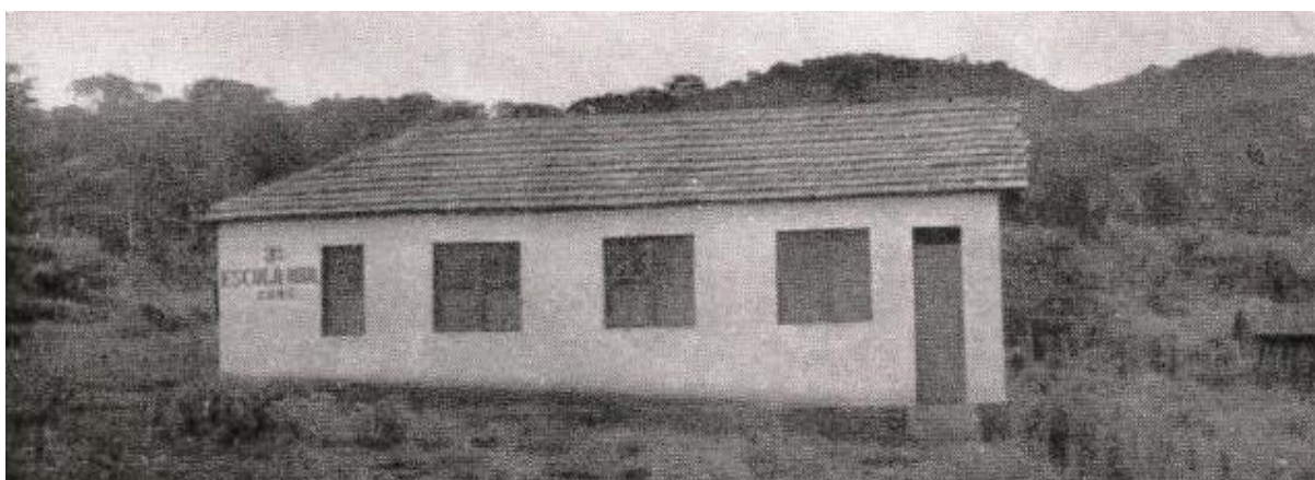
Figura 2 – Escola Rural da Colônia Agrícola Nacional de Goiás – CANG. Fonte: Faissol (1952, p. 86e).
