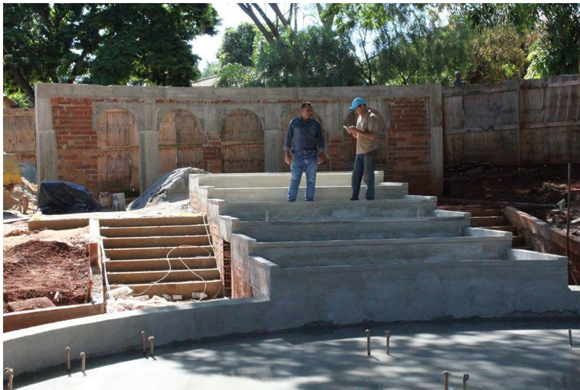
Ilustração 51 – Fonte luminosa na Praça João Stival em fase final de construção
