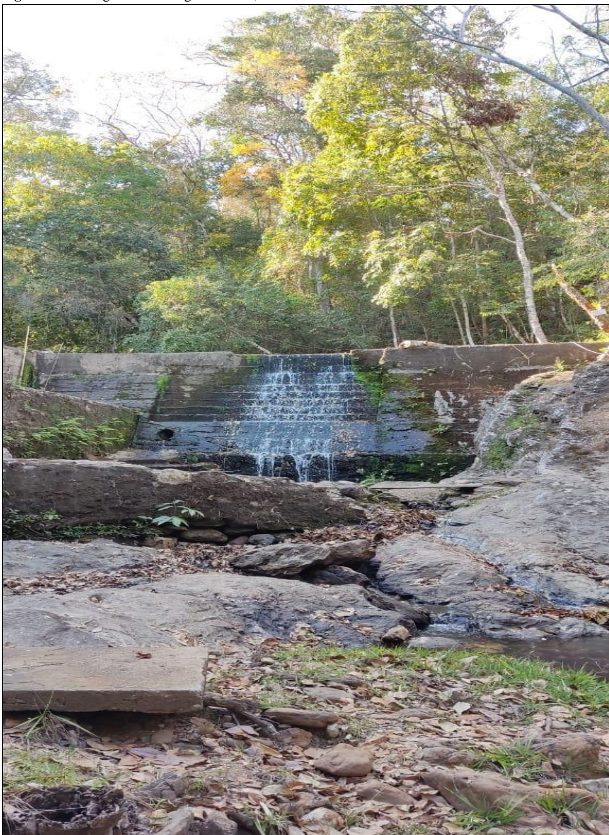
Figura 15. Barragem do Córrego Cafundó, Serra Dourada.
