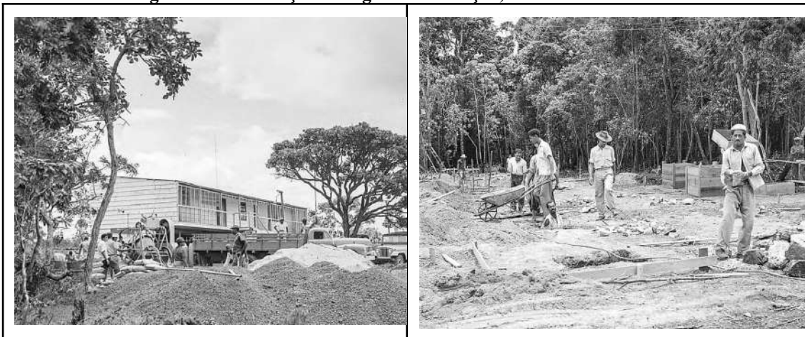
Figura 16: Construção da segunda edificação, o Catetão. Dezembro de 1956.
