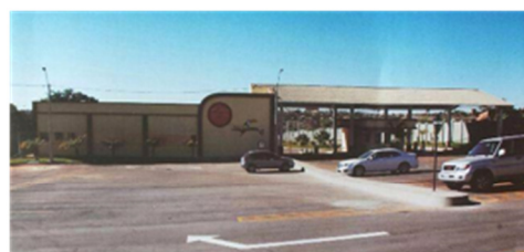
5 Portaria Condomínio Vale dos Pássaros (2010) Fonte: Site Olx, 2016.
