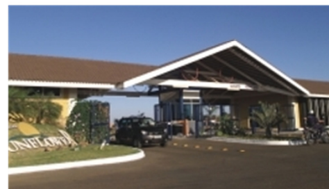
4 Portaria Condomínio Sunflower (2000) Fonte: Site Elmo Engenharia, 2016.
