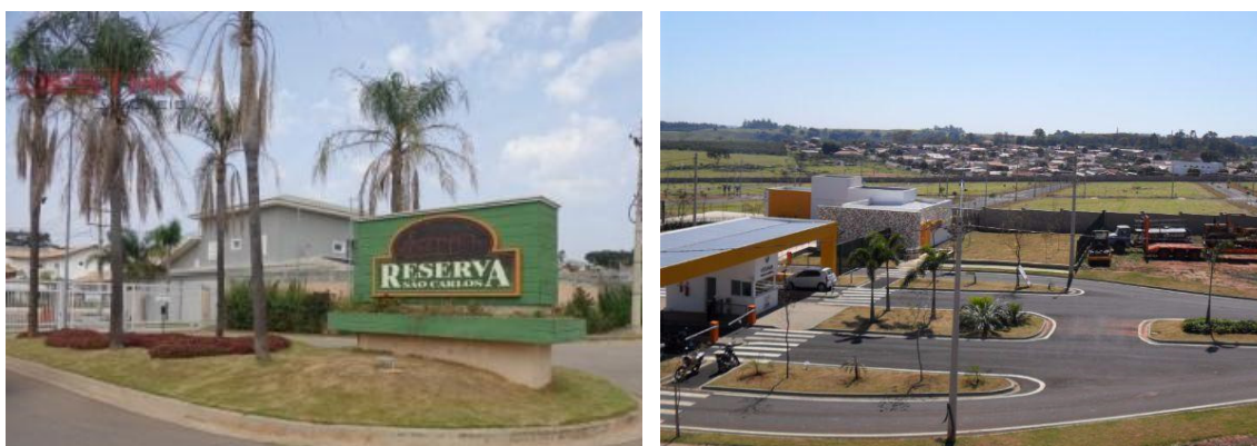
Figuras 5 e 6 respectivamente: Condomínio Reserva em São Carlos – SP e Condomínio Residencial Verana Parque Alvorada em Marília-SP.
