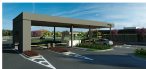
3 Portaria Condomínio Alphaville (2013) Fonte: Site Alphaville, 2016.
