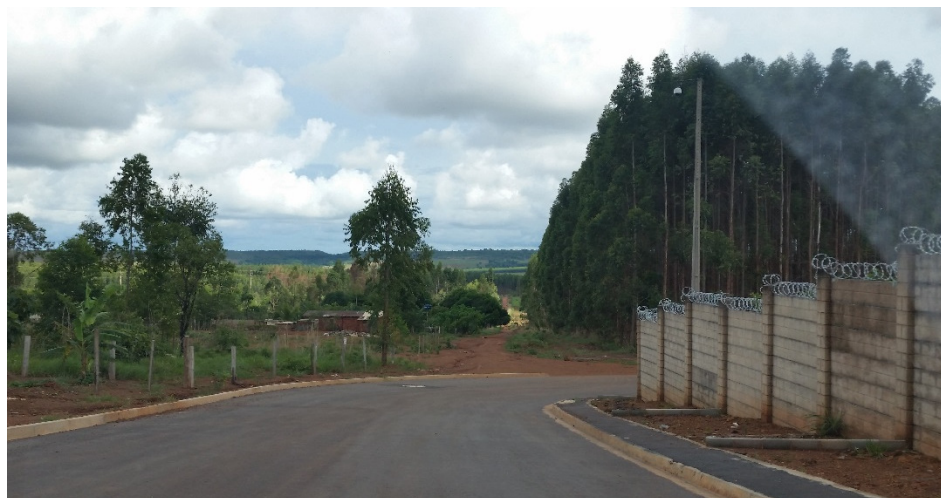
Figura 38: Muro e entorno do Condomínio Anaville.
