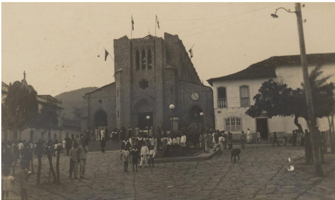
Figura 02: Igreja de Nossa Senhora do Rosário, Cidade de Goiás.
