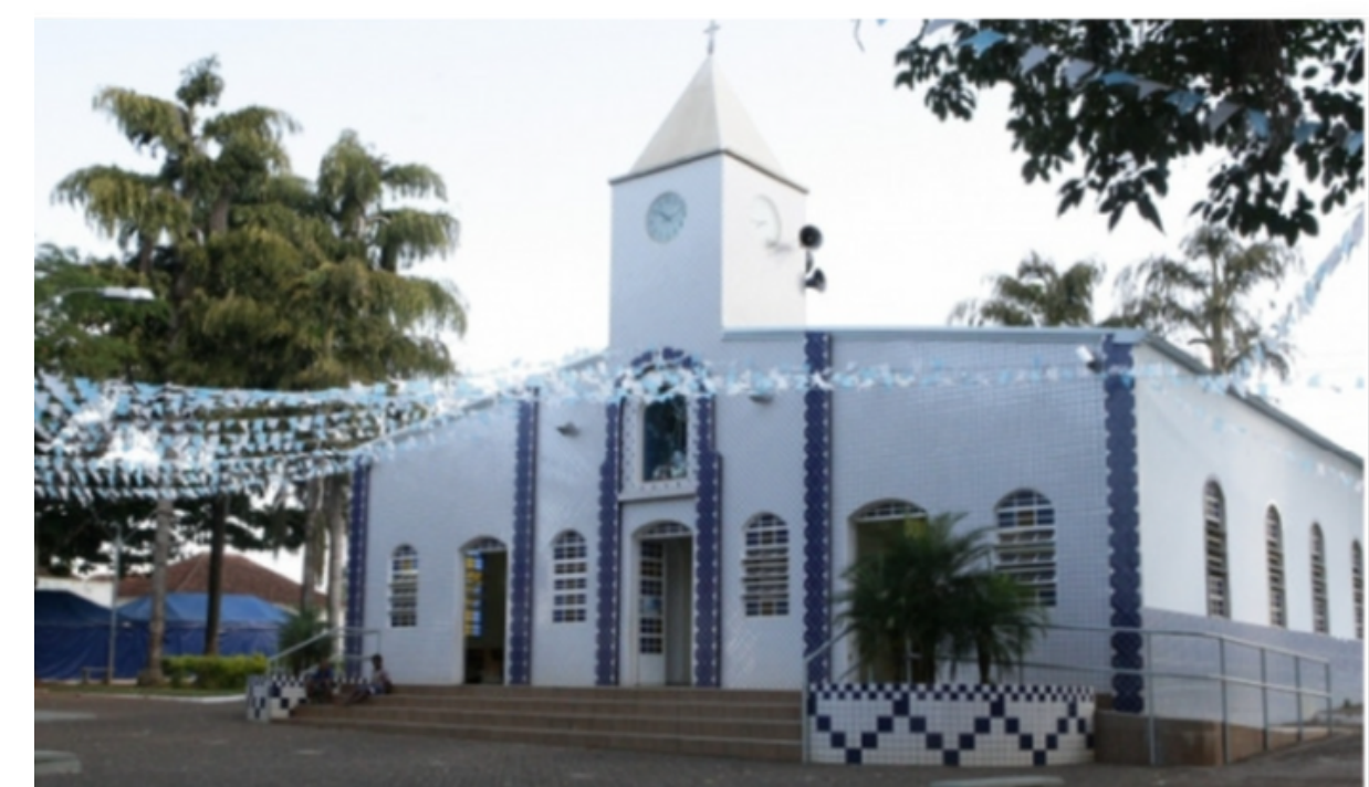
Igreja N. S. Abadia. Foto: SECOM/PMU.
