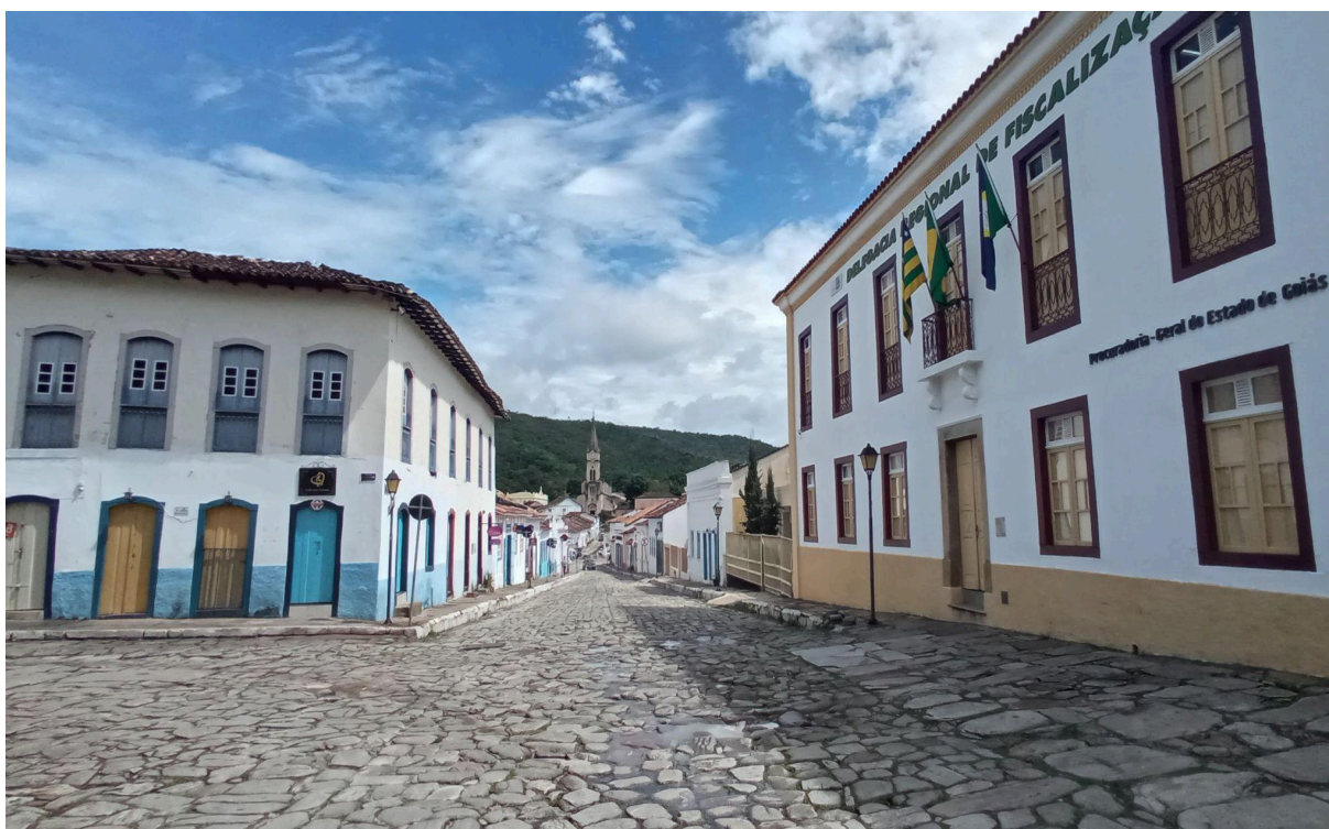
Figura 39 — Fotografia da Rua Moretti Foggia em 2024
