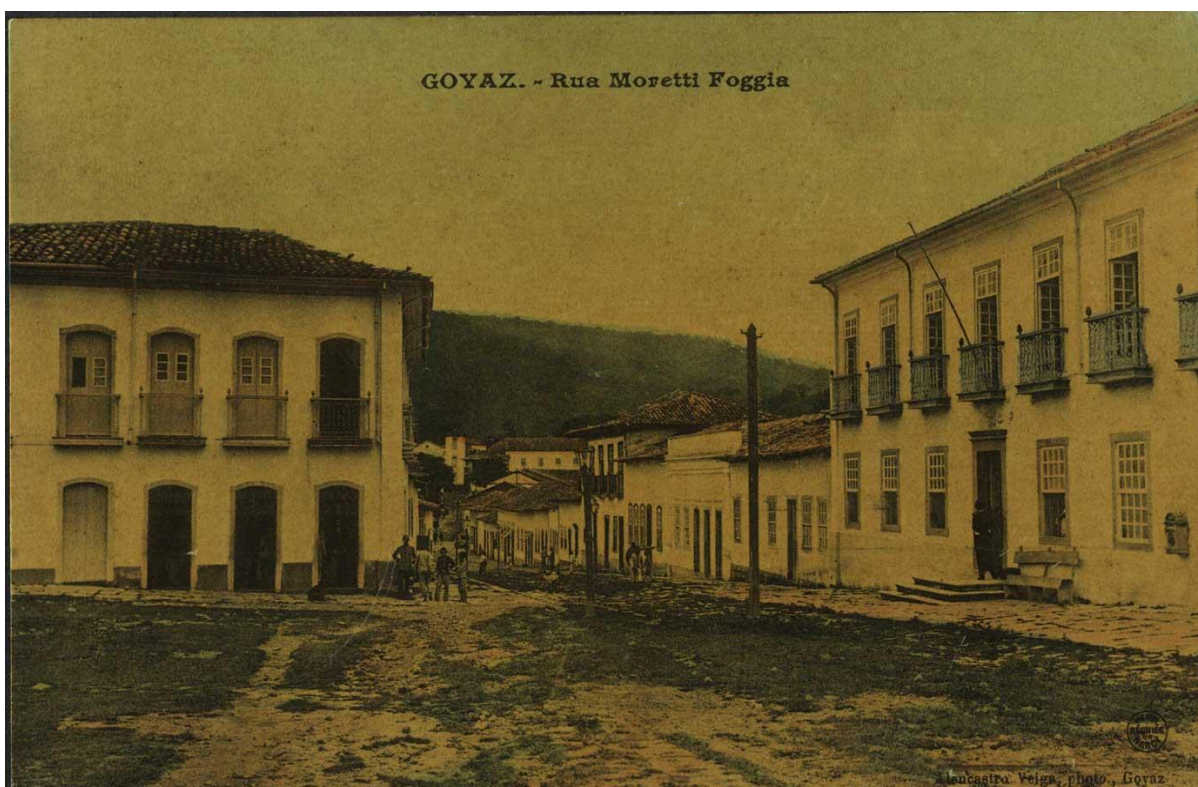
Figura 35 — Fotografia da Rua Moretti Foggia em 1908
