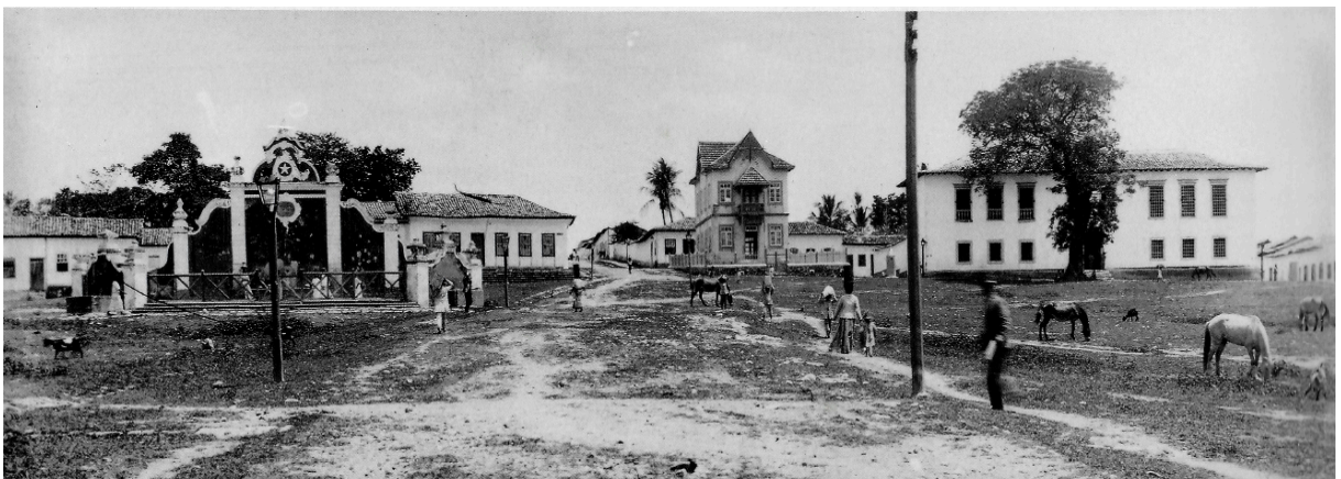
Figura 26 — Fotografia do Largo do Chafariz - Rua Nova (1911–1915)
