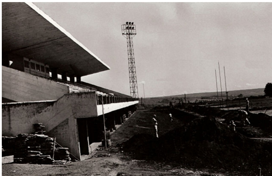
Figura 18 - Construção da primeira arquibancada do Estádio Municipal
