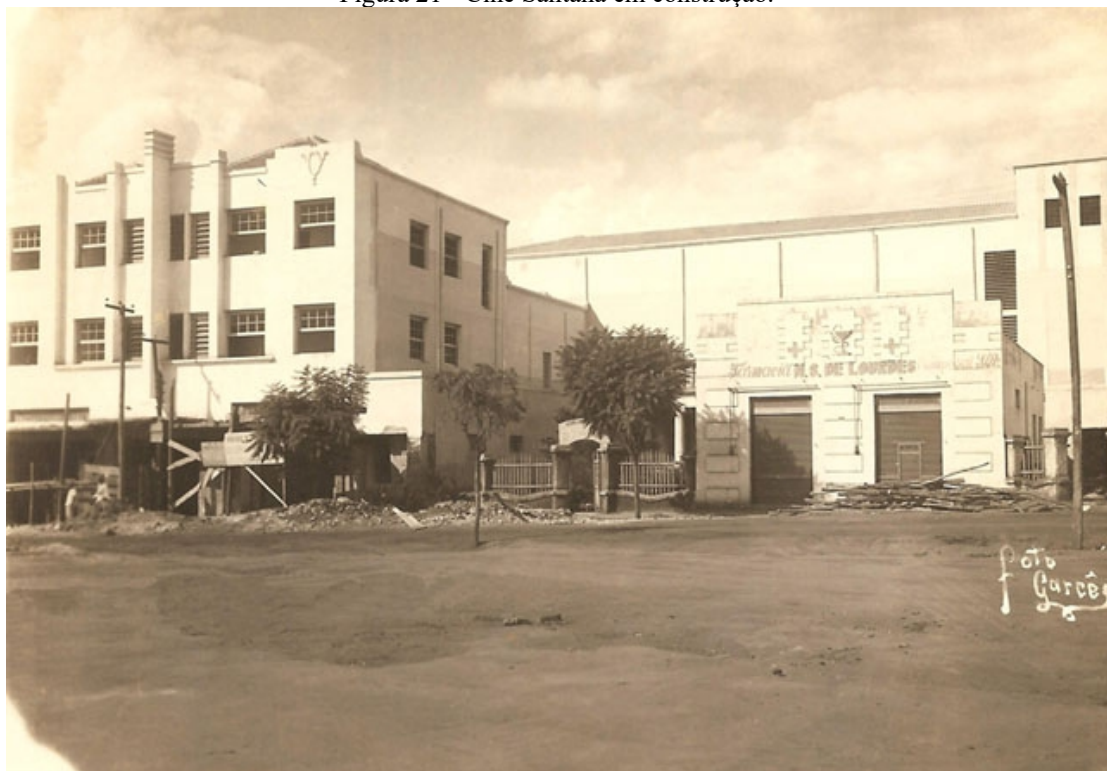
Figura 21 - Cine Santana em construção.
