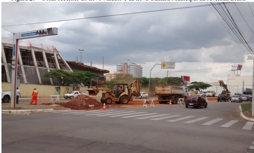
Figura 29 - Obras recentes do novo viaduto e da nova Câmara Municipal na Avenida Brasil
