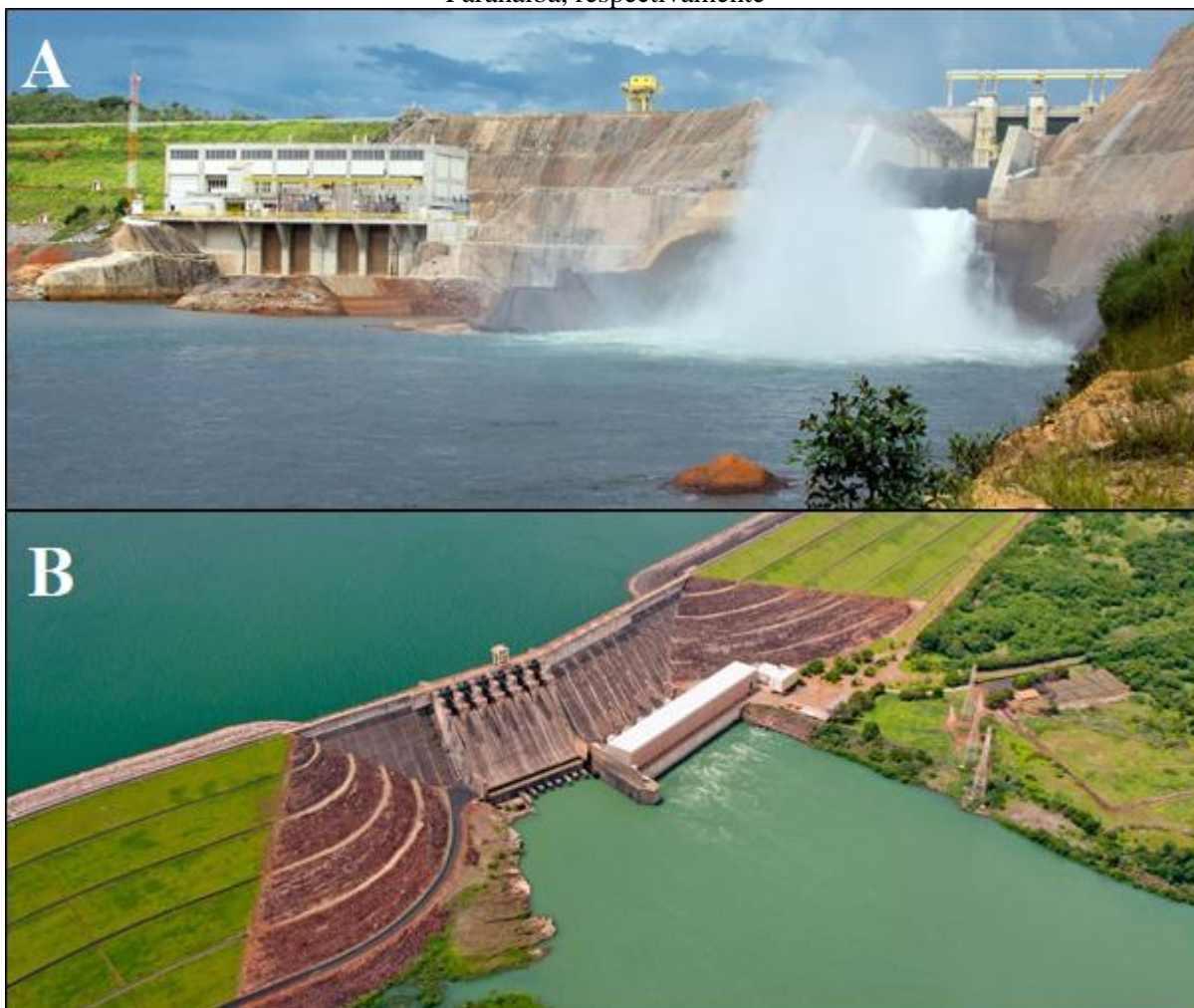
Figura 20 – Barragens das Usinas Hidrelétricas Batalha (A) e Itumbiara (B), no rio São Marcos e Paranaíba, respectivamente
