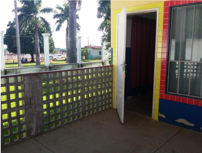
Figura 12 – Vista da área externa da sala de aula
