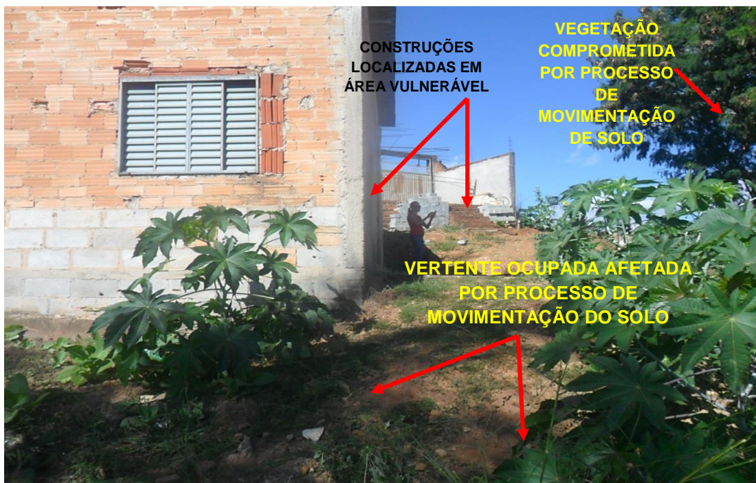
Ilustração 18 – Ocupação de encosta instável. Residência comprometida pelos escorregamentos do solo.
