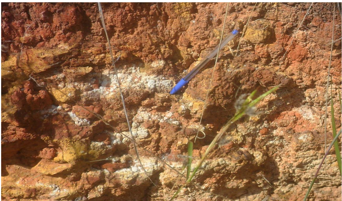
Ilustração 22 – Cobertura superficial alterada sustentando algumas edificações na região Noroeste de Anápolis
