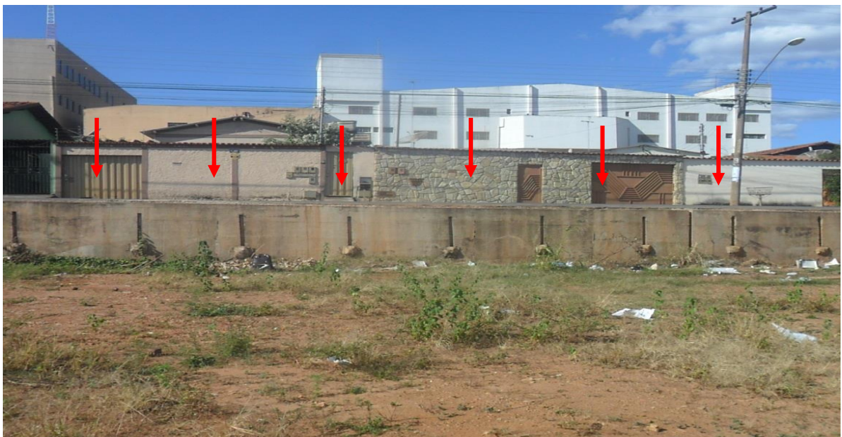
Ilustração 31 – Parede de contenção de processo erosivo situado à Rua Leopoldo de Bulhões
