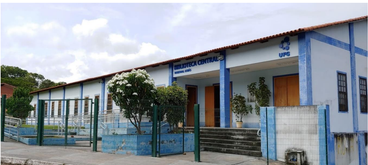
Figura 4 - Fachada da nova biblioteca - UFG Campus Goiás
